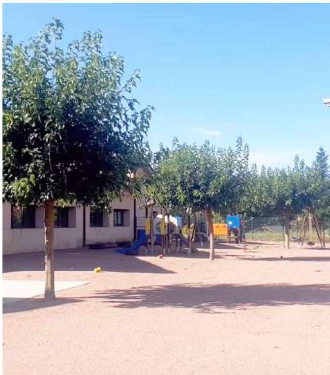
Estat actual del pati de l'escola
