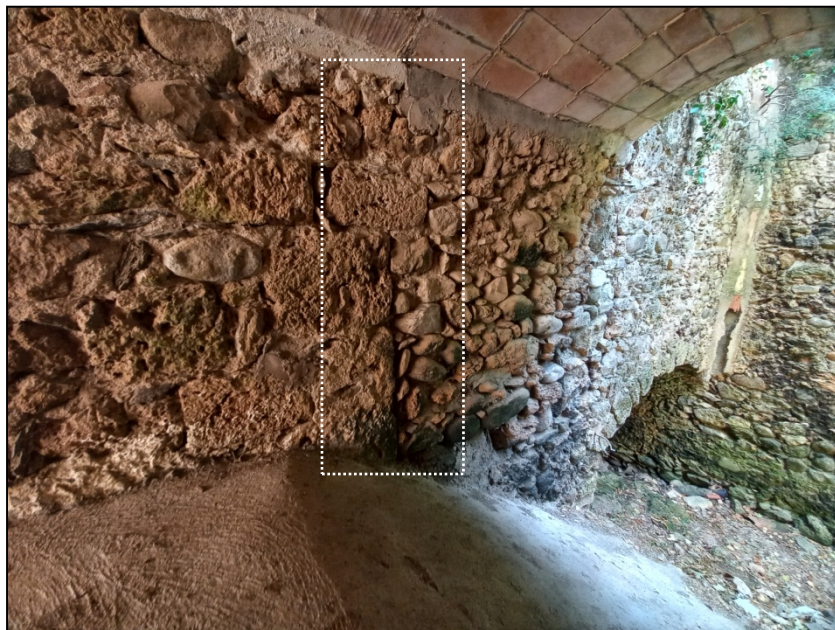
Vista del canvi de paraments que es troba en el porxo que comunica el carrer de l'Oli amb la Riera de les Escaules. En aquest cas la línia més antiga ve marcada per blocs de pedra tosca.
