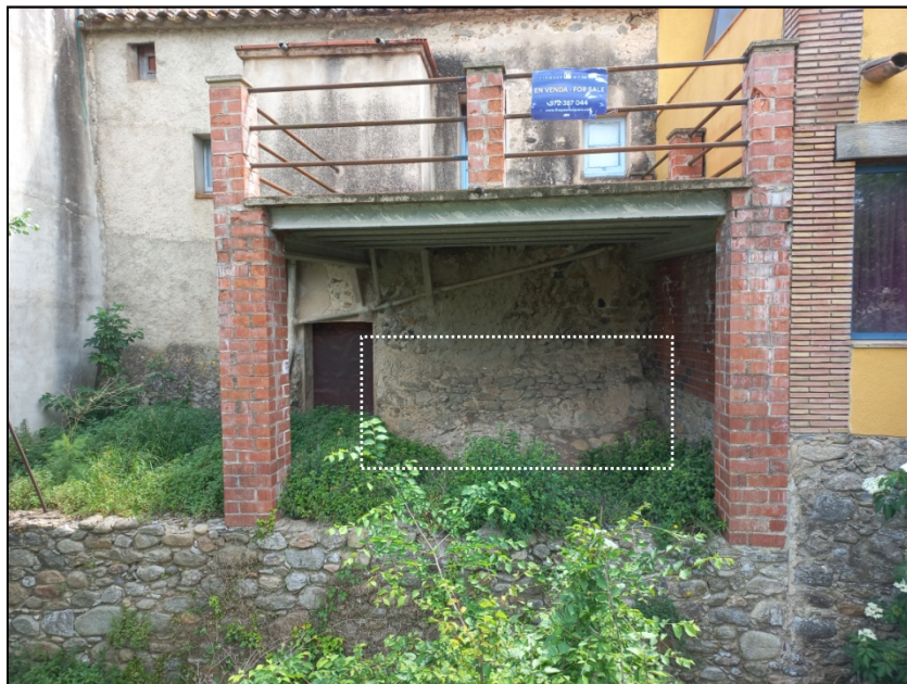
Vista de la façana nord de la finca número 6 del carrer de la Processó, on s'aprecia un parament inferior semblant al de la muralla.
