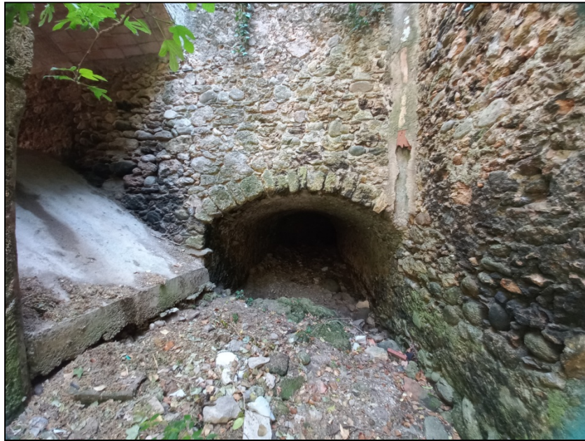
Vista de l'extrem est de la Riera de les Escaules que es troba parcialment coberta.
