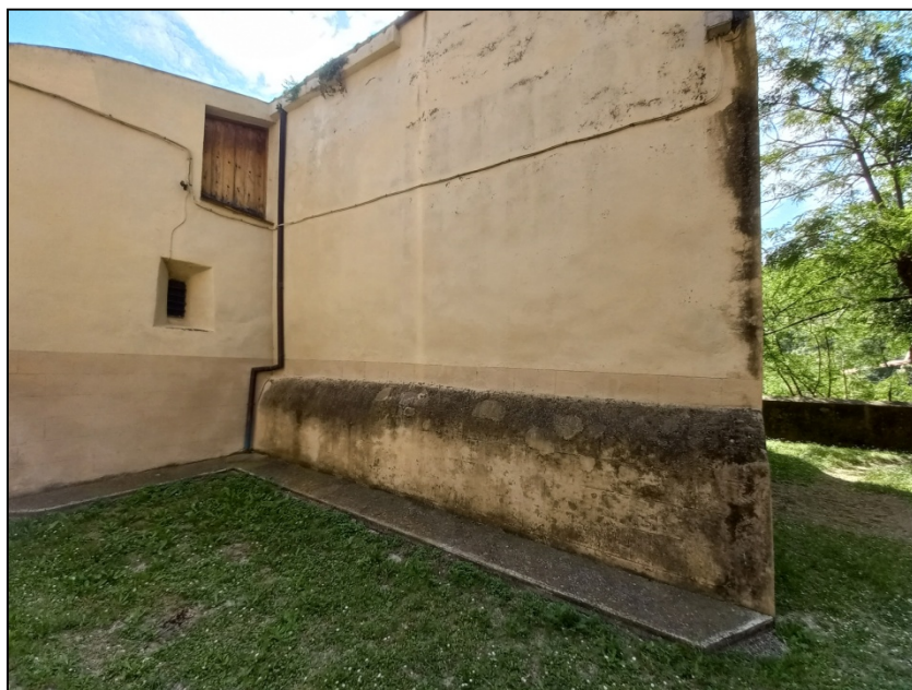
Vista del mur nord de l'església que presenta la cara exterior amb una base engruixida, que podria estar relacionada amb la muralla.
