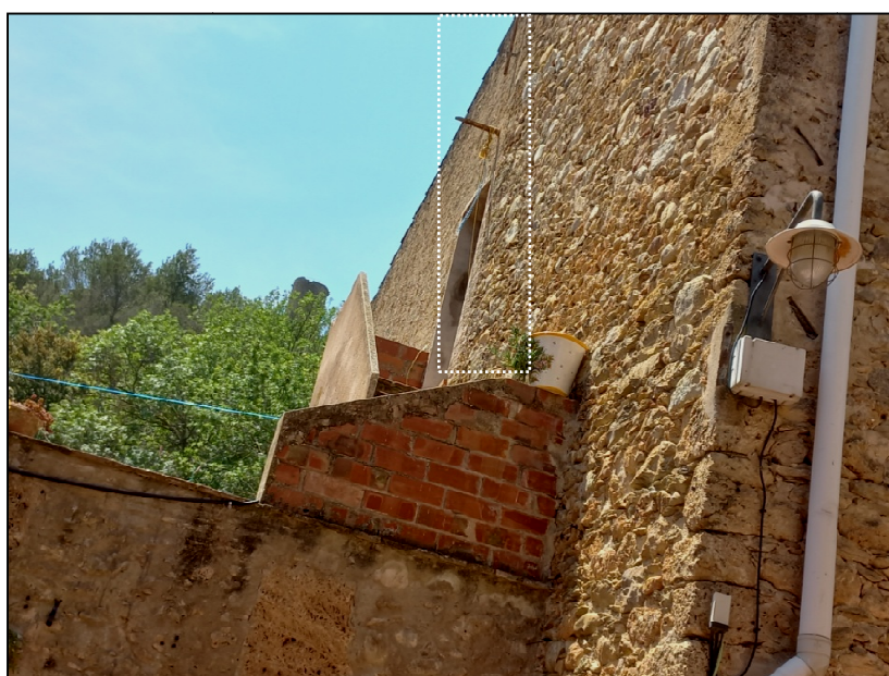
Vista de la part posterior de la casa del carrer de l'Oli, 1 on s'aprecia la línia de dues fases constructives.
