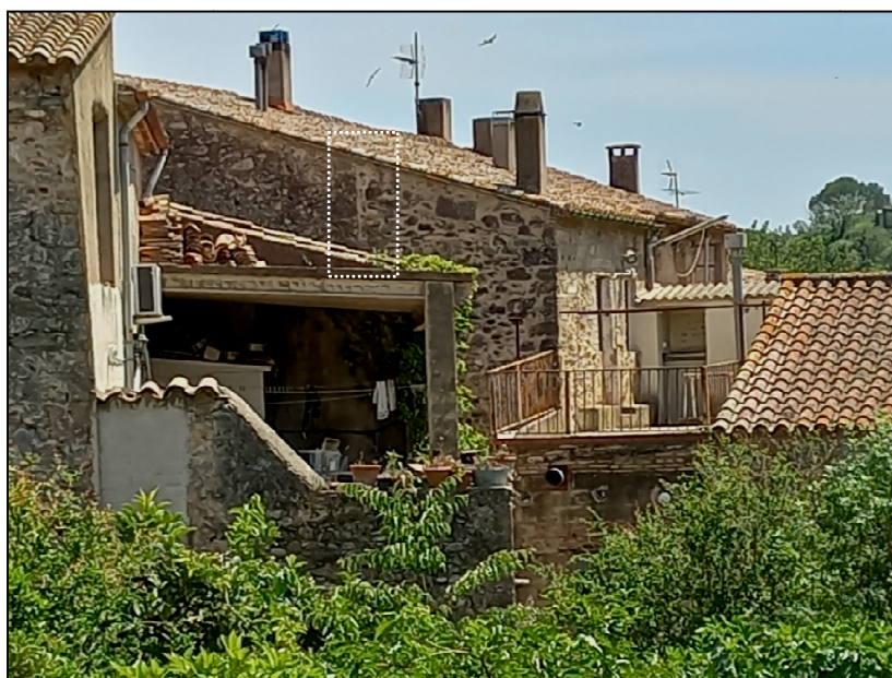
Vista de la part posterior de la casa del carrer de l'Oli, 7 on s'aprecia la línia de dues fases constructives.
