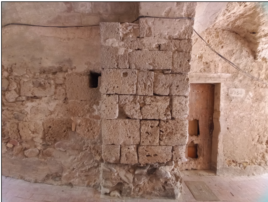
Detall del brancal nord del portal que conserva el forat per col·locar el berrat i tancar la porta.
