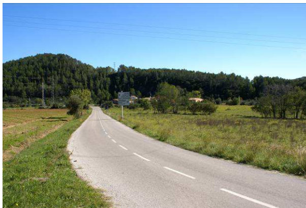
Figura 4.2. Carretera comarcal GI-504 al seu pas pel nord del nucli de Boadella
