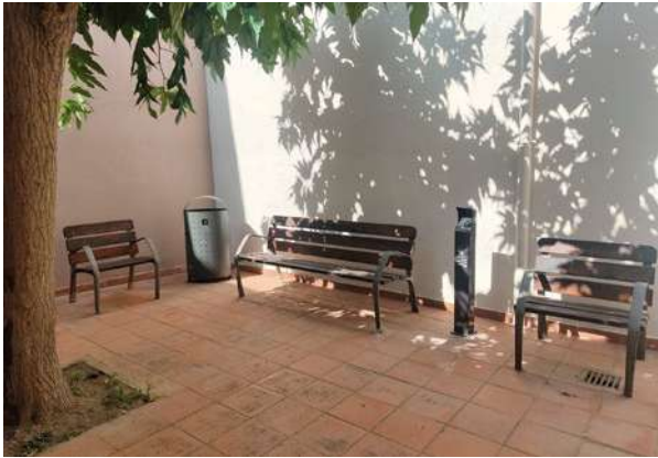
Instal·lació de bancs, paperera i cendrer a l'accés d'entrada a la Sala Nova.
