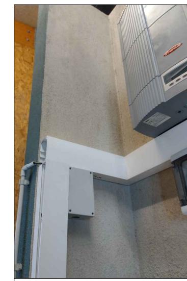
Imatge 2: Espai per on ubicar la canalització del cablejat provinent de la coberta inclinada
