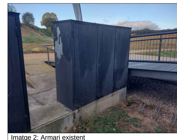
Imatge 2: Armari existent
