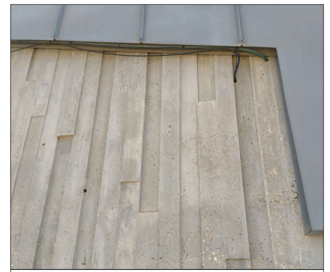
Imatge 3: Entrada des de la façana a l'interior de l'edifici del cablejat provinent de la coberta inclinada
