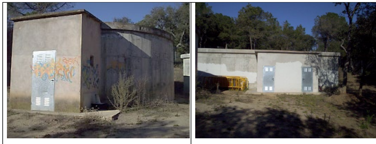
Figura 6 - Dipòsit Vell (esquerra) i Dipòsit Nou (dreta).
