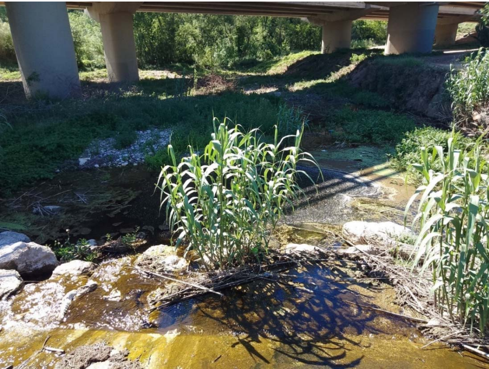
Figura 8. Vegetació actual al marge d’aigües avall del gual. Així doncs, atenent a les superfícies de vegetació afectades i al grau d’interès d’aquestes, s’avaluen les dues alternatives amb un impacte moderat en aquesta fase.
