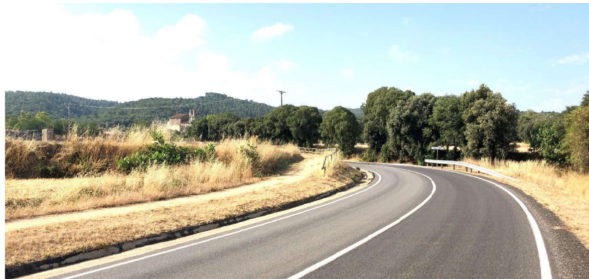
Entorn PK 1+500 a l'entrada a Juià
