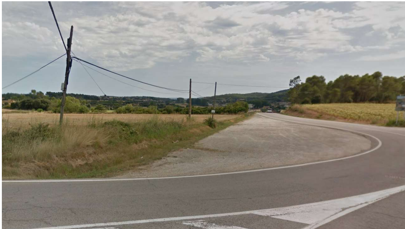
Figura 4. Inici tram de canalització de la GIV-6425.
