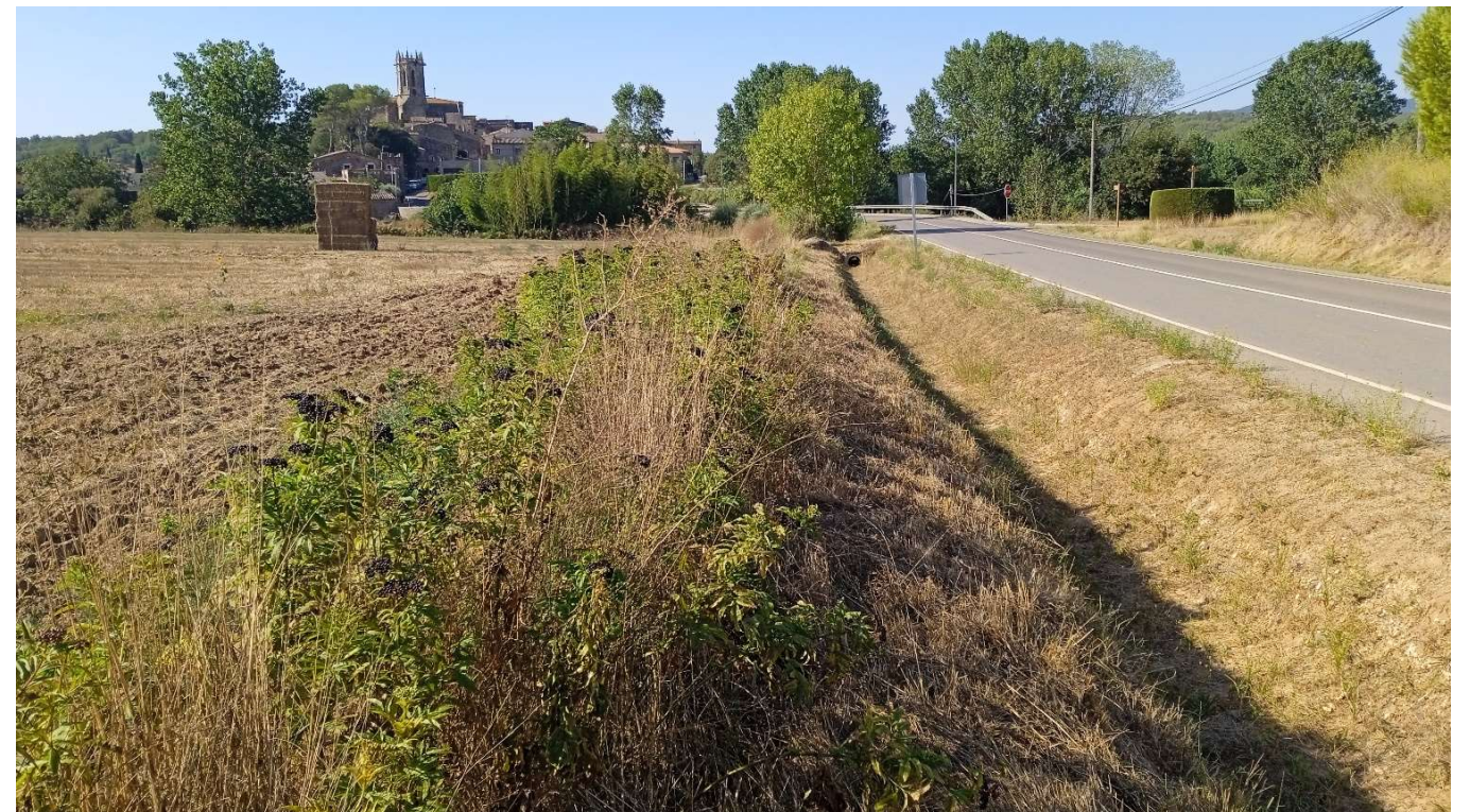
Figura 6. Tram de canalització pel domini públic del marge esquerre (S4A).
