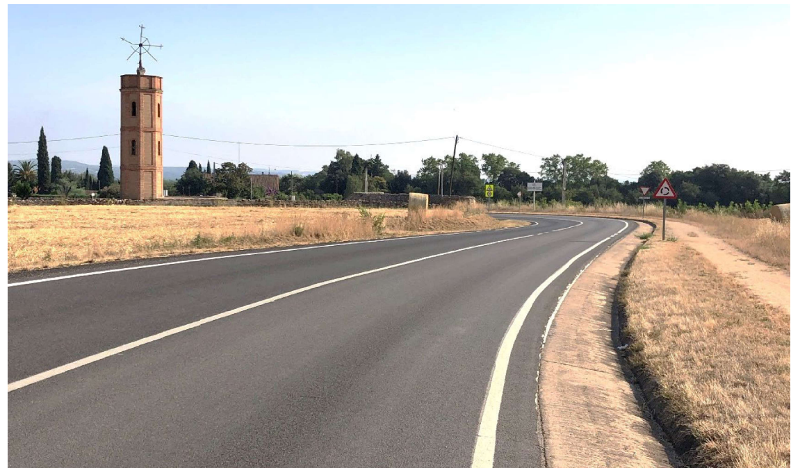
Torra d'aigua situada a peu de la carretera (PK 1+350)
