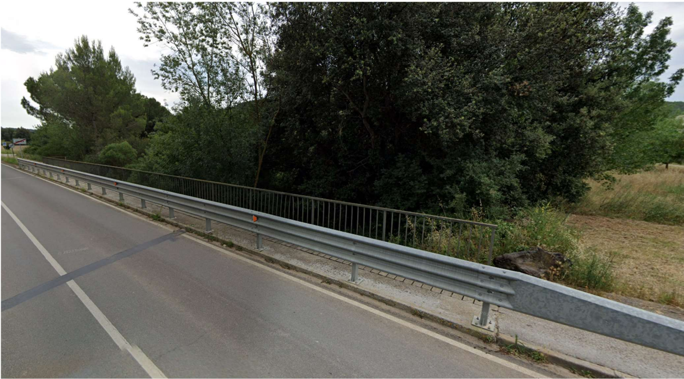
Figura 2. Creuament de la riera de Palagret amb perforació horitzontal dirigida.
