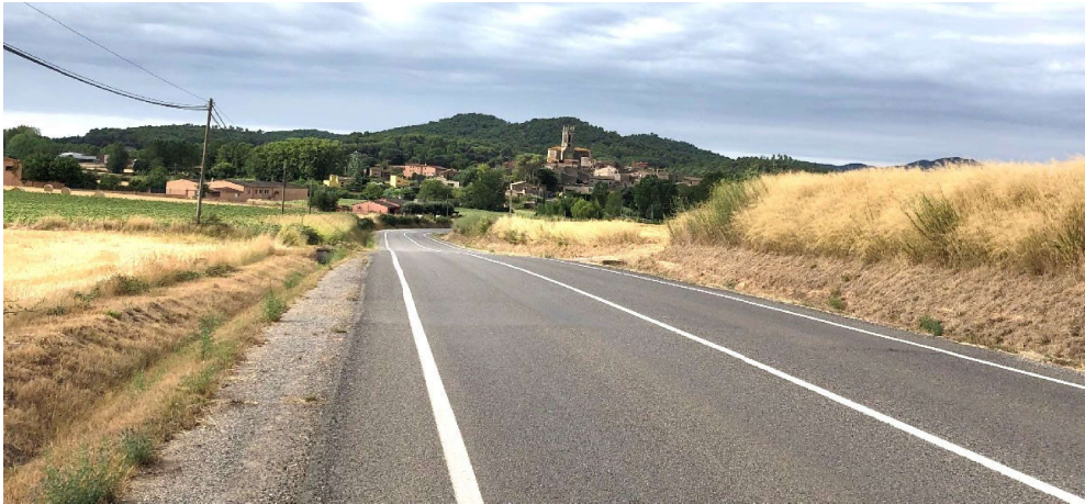
Entorn PK 0+500 amb la Pera com a fons escènic
