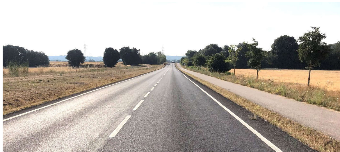
Entorn PK 0+300 amb el carril bici a la dreta
