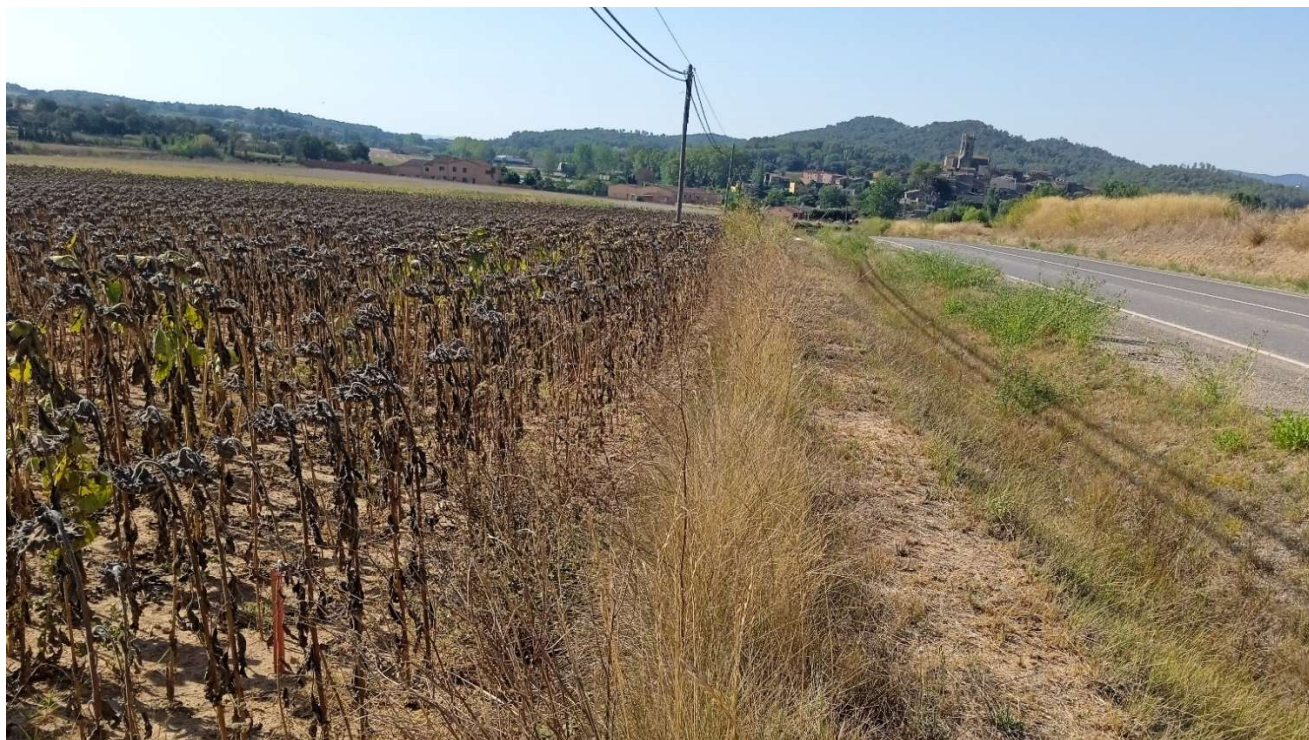
Figura 5. Tram de canalització pel domini públic del marge esquerre (S4A).
