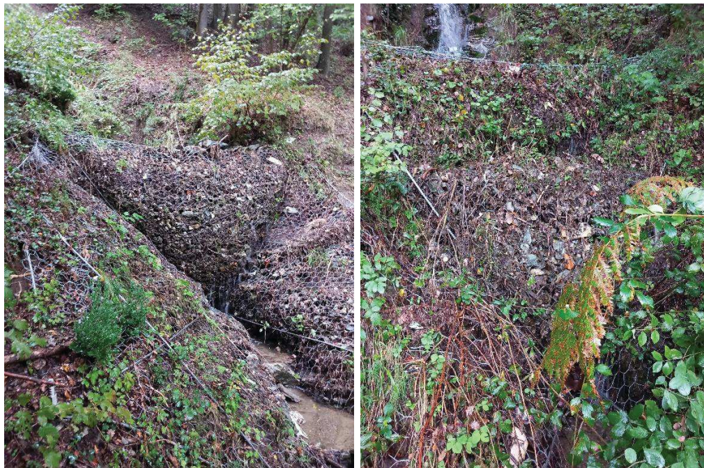
Figura núm. 16. Acumulació de terres a la malla DT
