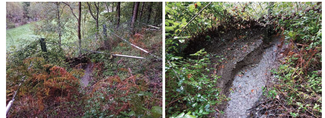
Figura núm. 18. Acumulació de sediments transportats pels fluxos a la base de la barrera dinàmica.
