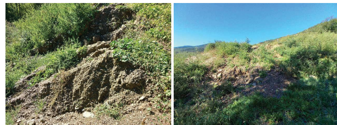
Figura núm. 19. Xaragalls a l'extrem sud-est del dipòsit.
