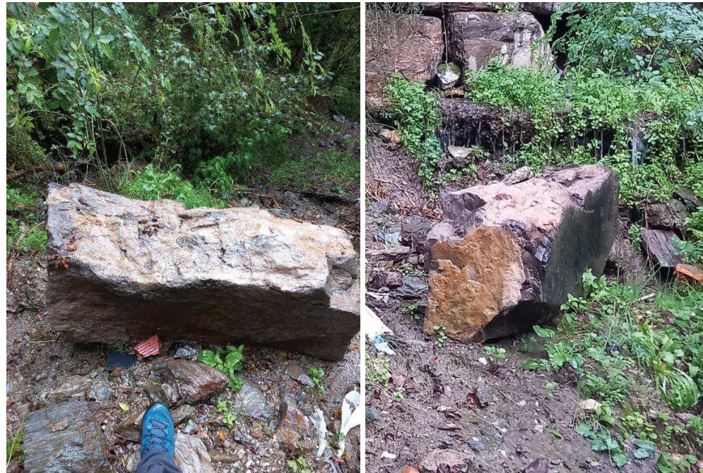
Figura núm. 15. Peces d'escullera mobilitzades aigües avall.
