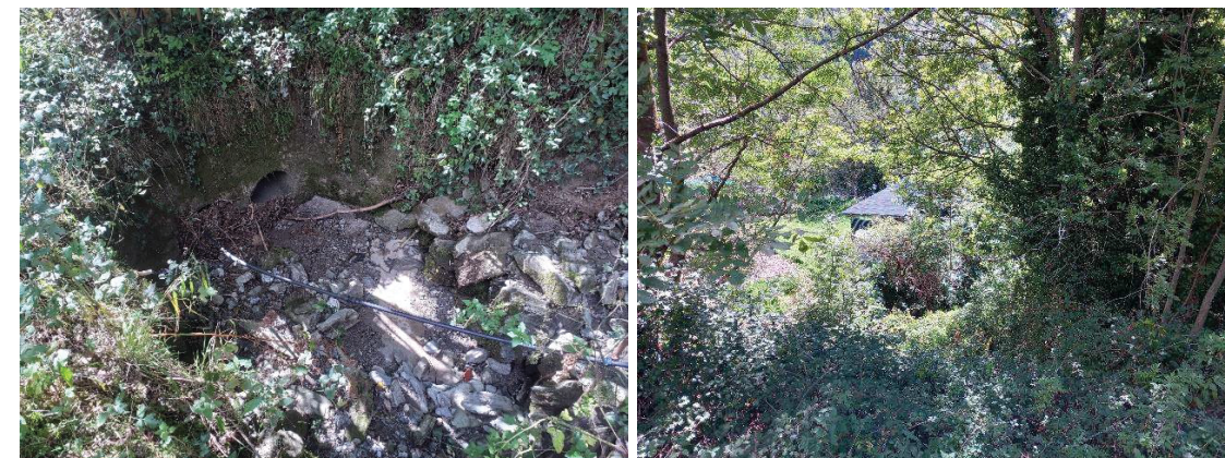
Figura núm. 8. Respectivament, entrada i sortida del drenatge transversal NU21DT06276.
