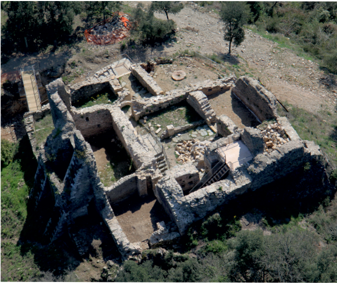
Vista aèria del conjunt en procés de restauració
