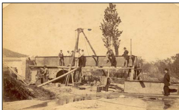
Obres de construcció del pont sobre el Ridaura Foto de l'Arxiu Municipal de Sant Feliu de Guíxols
