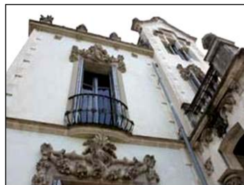
Can Nadal (Cassà de la Selva) Edifici eclèctic amb elements modernistes
