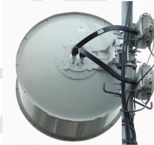
**Instalación de montaje separado con una antena de polarización doble**
