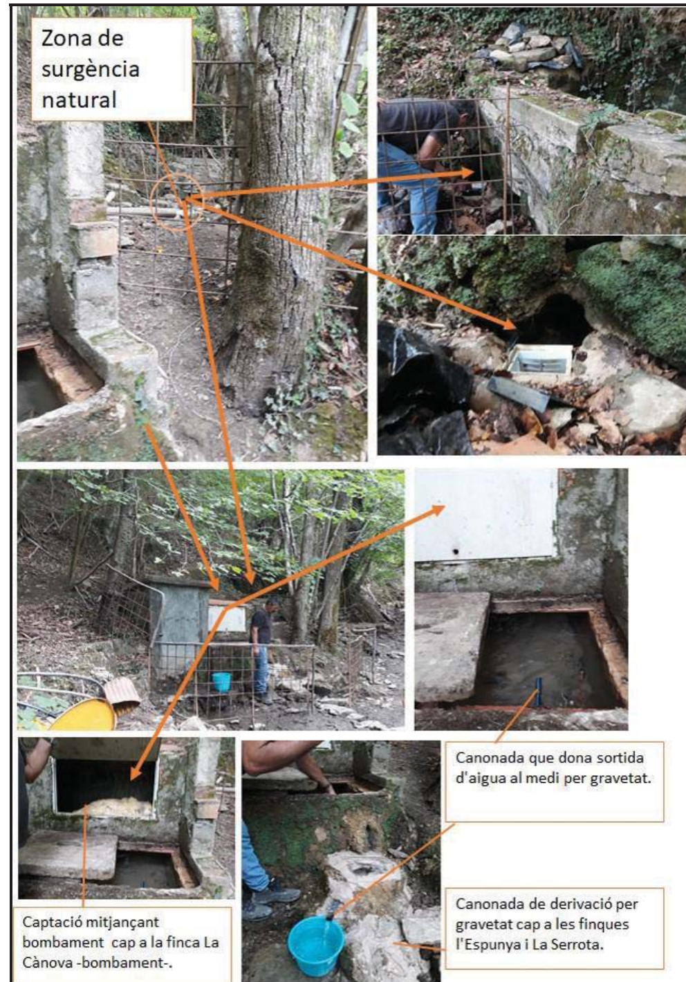
Figura 1 Esquema explicatiu de les captacions de la FONT LA CANOVA (ANDUY).
