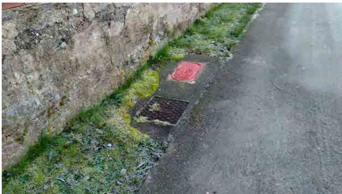
Fotografia 8. Vista arquetes existents.
