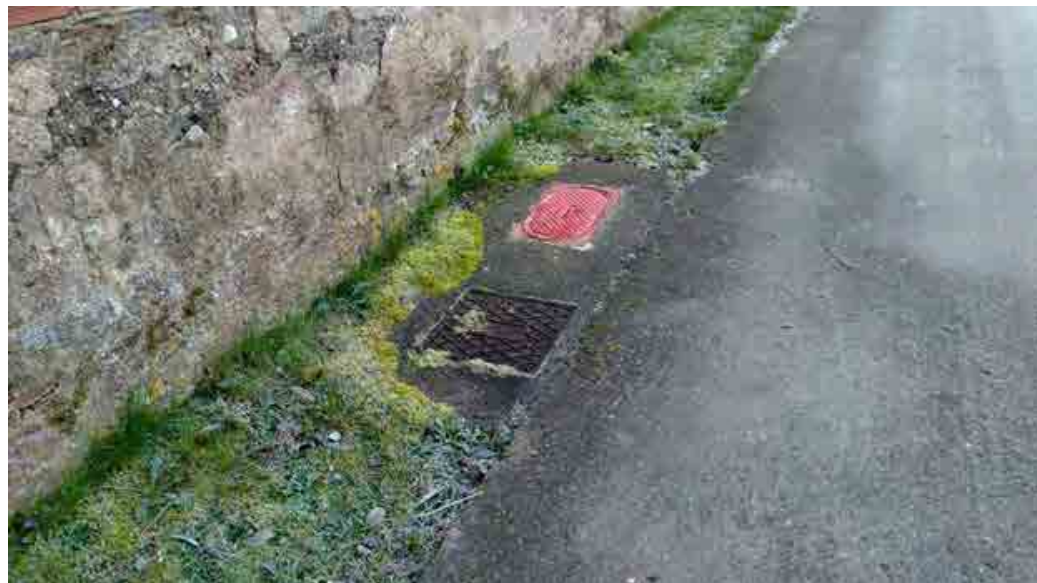
Fotografia 4. Vista arquetes existents.
