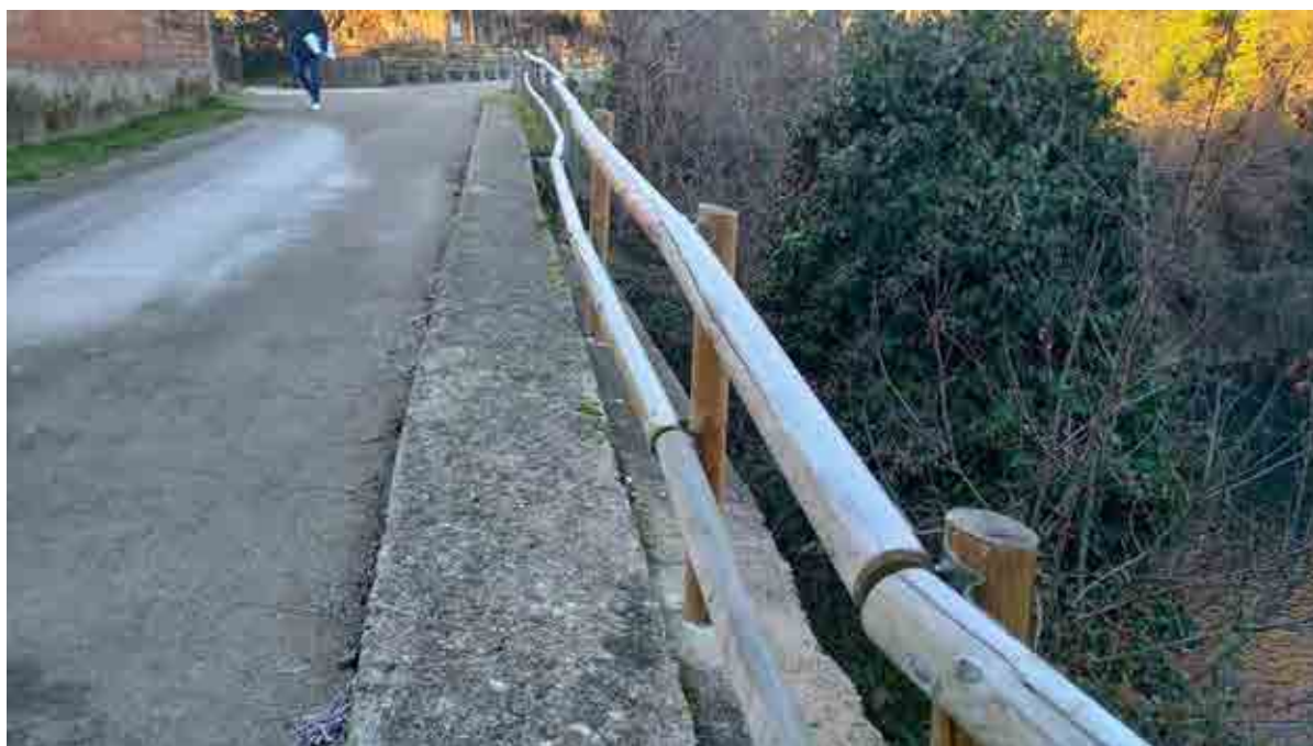
Fotografia 7. Vista el mur existent i tanca
