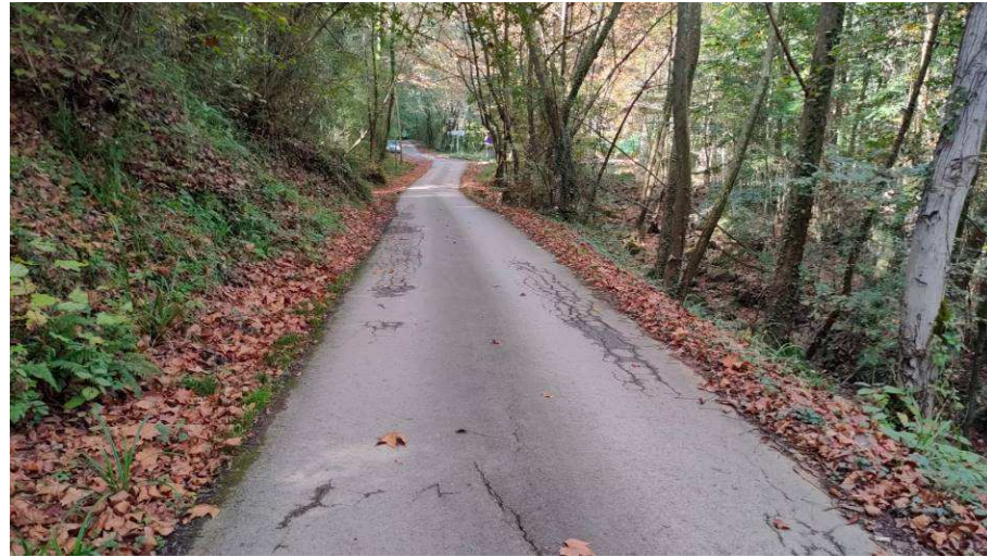
Fotografia 10. PK 3+850. Vista del ferm amb presència de flonjalls.
