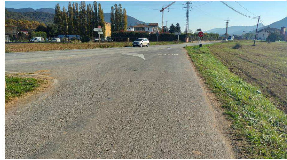
Fotografia 1. PK 0+000. Entroncament amb la carretera N-260.
