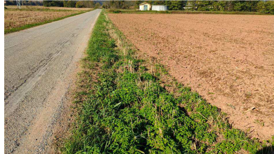
Fotografia 11. Vista de les cunetes de terres a netejar.
