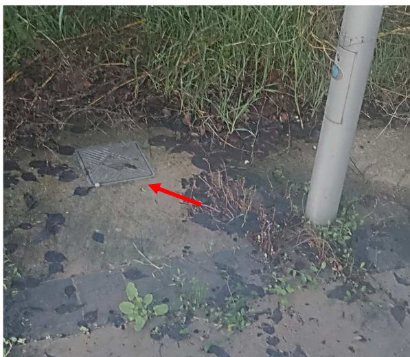
Figura 3 – arqueta d'aigua existent al carrer Canigó a on es farà la connexió de la nova xarxa
