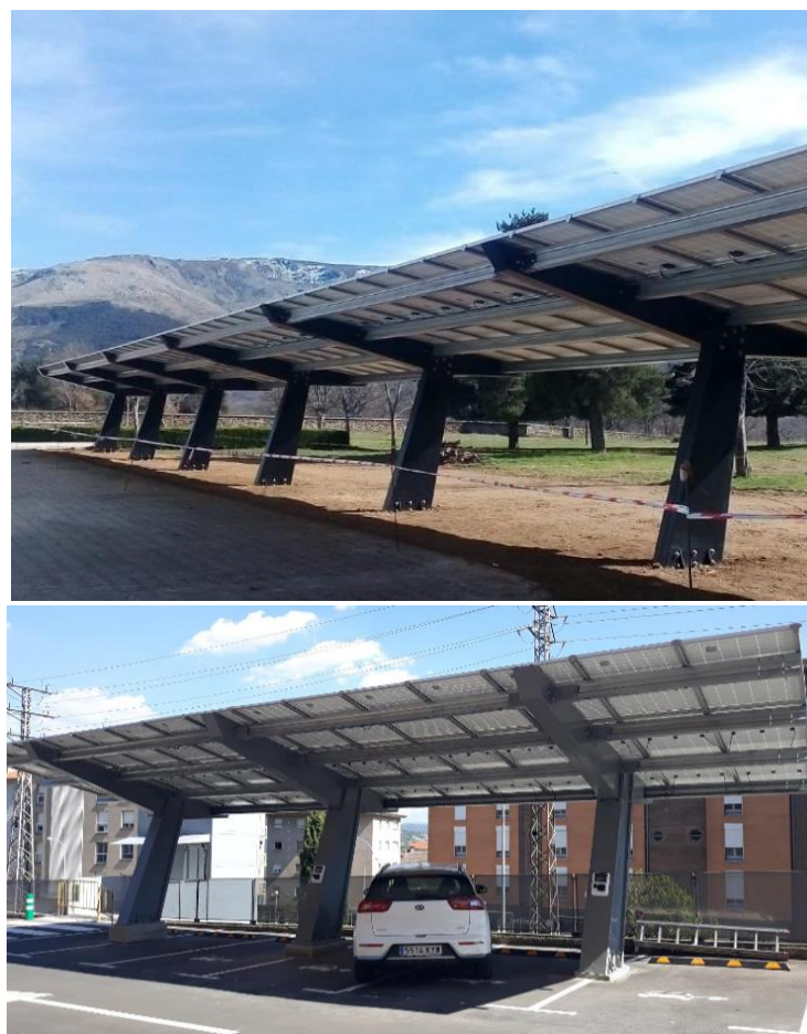
Figura 10. Exemples de la marquesina FV proposada. Font: Circutor.
