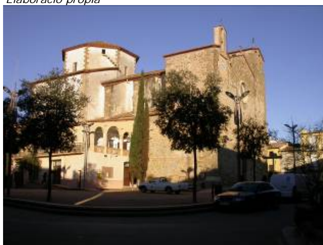
Figura 5.3-4 Equipament existent a Tortellà. Església parroquial de Tortellà Font: Elaboració pròpia
