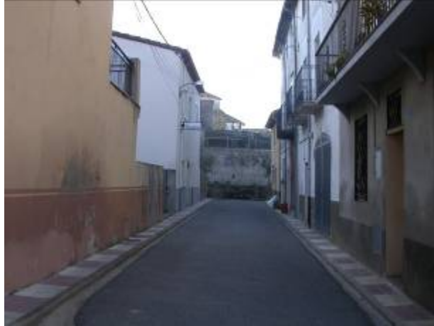
Figura 6.1-1 Carrer de Tortellà amb vorera no adaptada a l'accessibilitat Font: Elaboració pròpia
