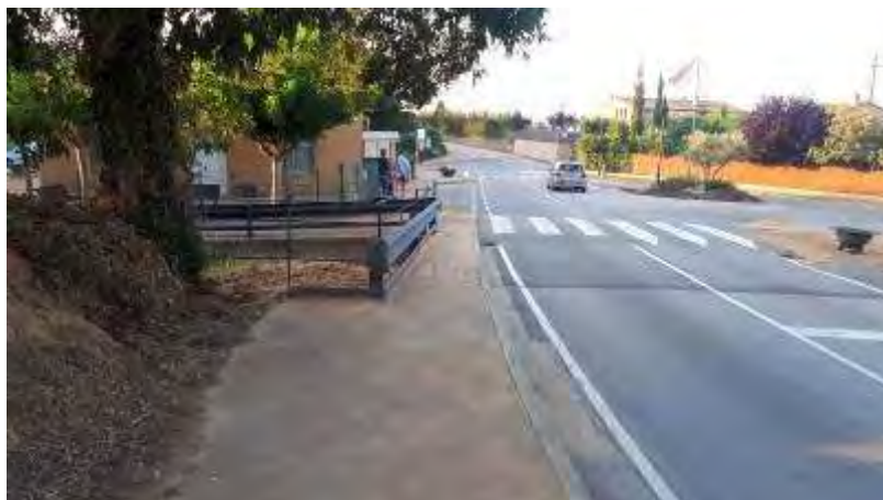
Figura 17. Estat actual Pont de la ctra. de Sant Feliu de Boada.
