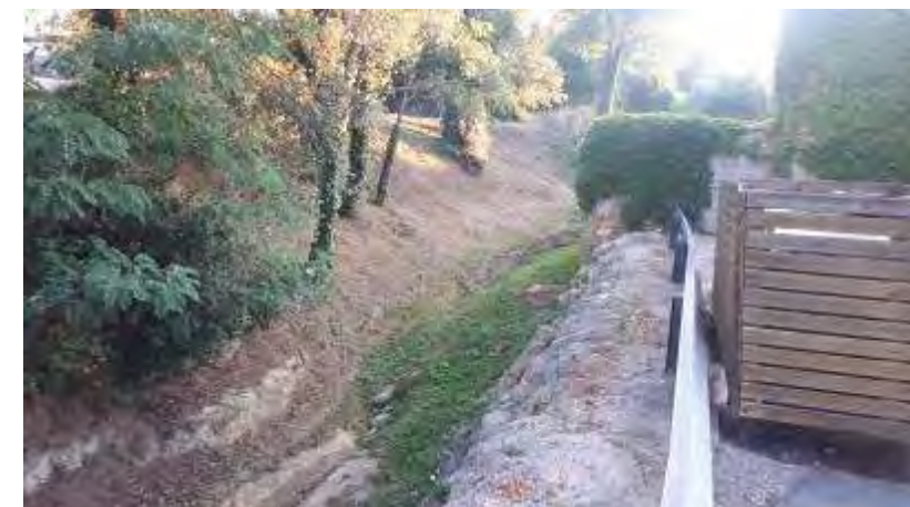
Figura 19. Estat actual riera de Torrent, aigües amunt del pont de la ctra. de Sant Feliu de Boada.
