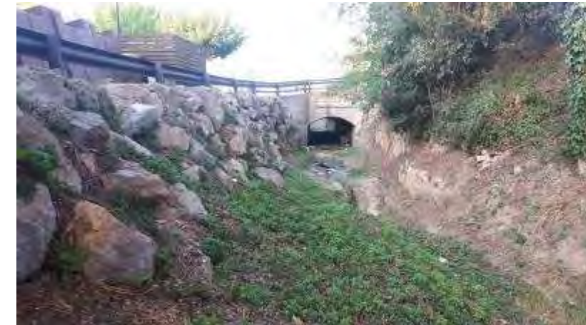
Figura 24. Estat actual riera de Torrent, aigües amunt del pont de la ctra. de Sant Feliu de Boada.
