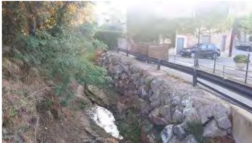
Figura 15. Estat actual riera de Torrent aigües amunt del Pont.
