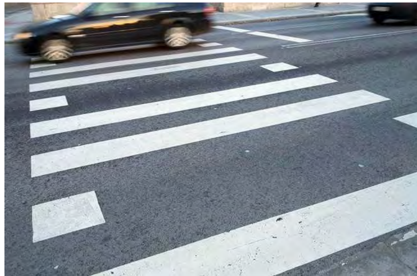
Figura 165. Pas de peatons amb reducció de pintura.
