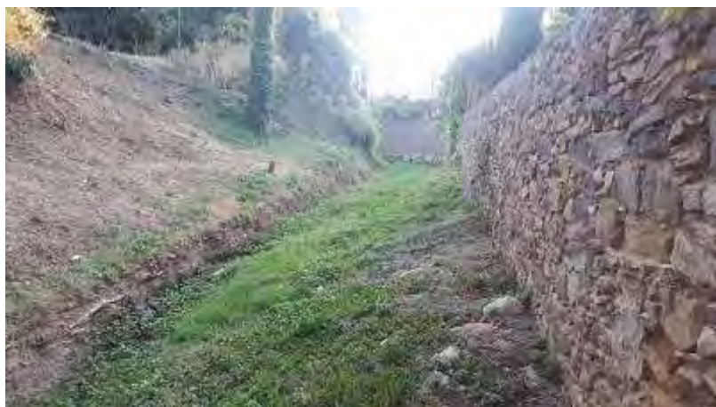
Figura 22. Estat actual riera de Torrent, aigües amunt del pont de la ctra. de Sant Feliu de Boada.
