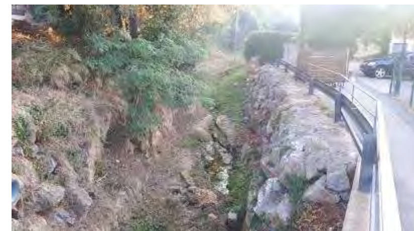
Figura 14. Estat actual riera de Torrent aigües amunt del Pont.
