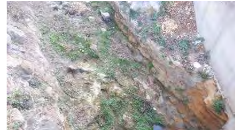
Figura 18. Estat actual entrada riera a la obra de drenatge del pont ctra. St. Feliu de Boada.
