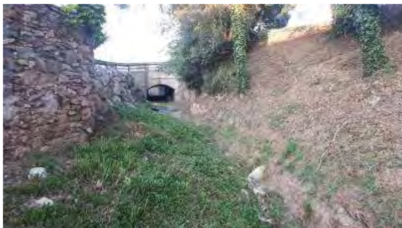
Figura 23. Estat actual riera de Torrent, aigües amunt del pont de la ctra. de Sant Feliu de Boada.
