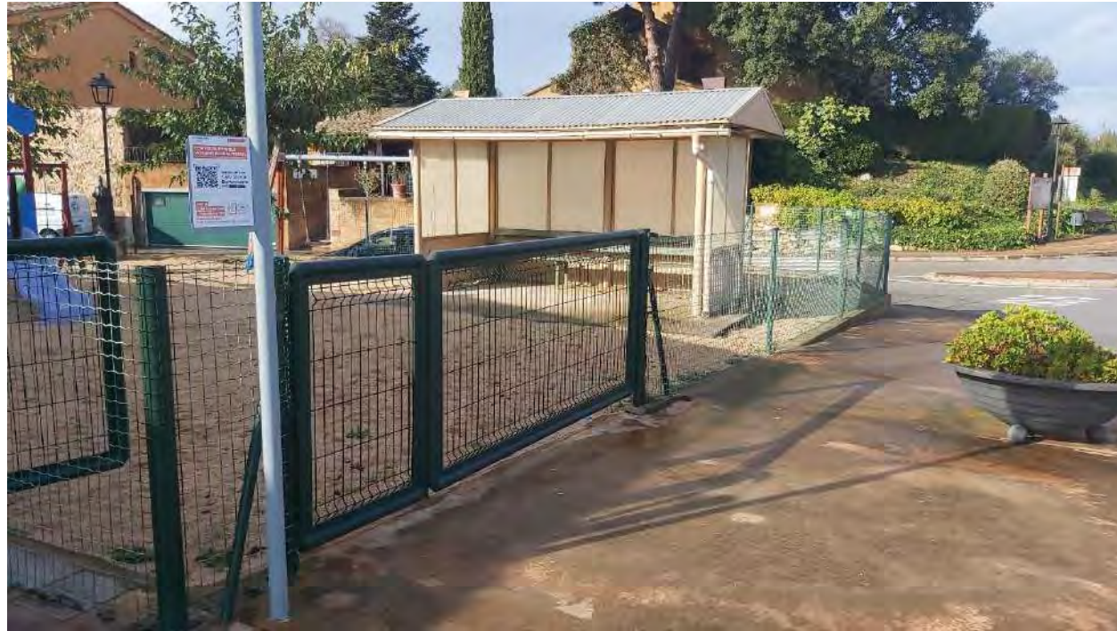
Figura 11. Imatge estat actual pati jocs infantils i marquesina bus.
