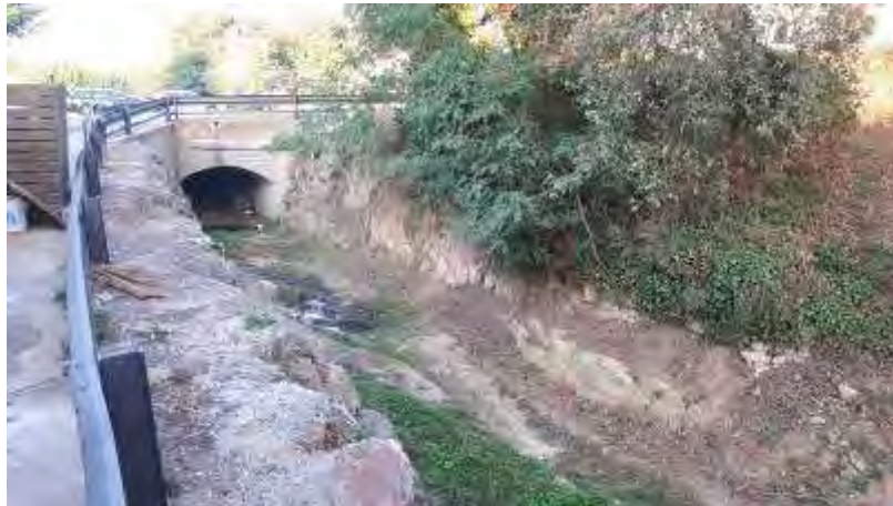
Figura 21. Estat actual riera de Torrent, aigües amunt del pont de la ctra. de Sant Feliu de Boada.
