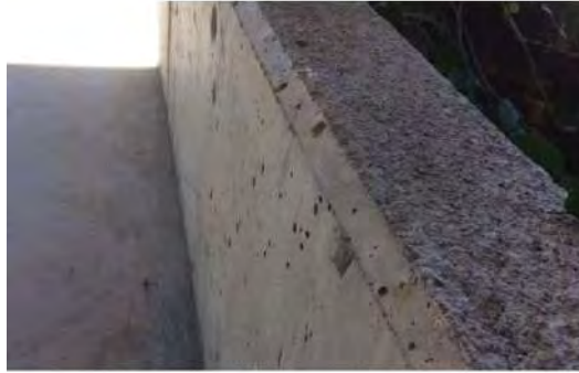
Figura 85. Imatge amb acabat bisellat coronació mur de formigó
