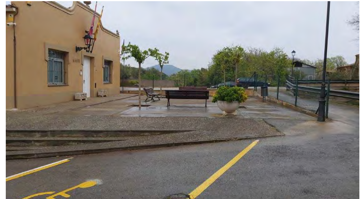
Figura 9. Estat actual façana sud edifici Ajuntament.
