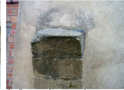
detall arrancada oest arc desaparegut
