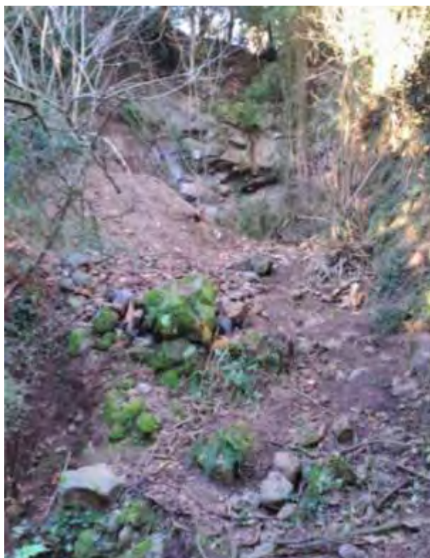
Restauració de l'abocament incontrolat al Pla de Sant Joan (estat posterior als treballs)
