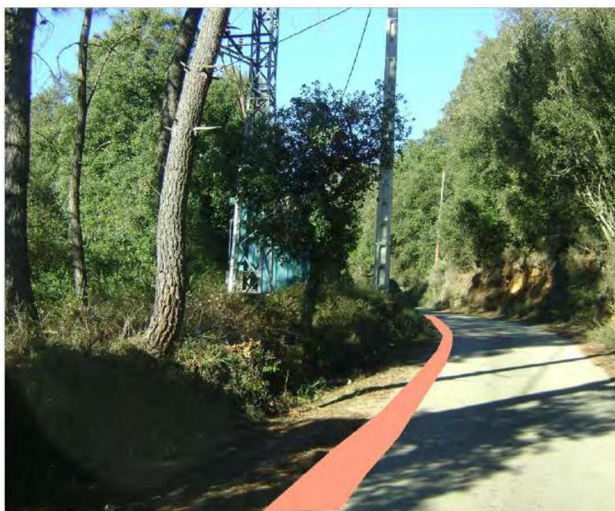
Imatge 10: Traçat de la rasa per la línia de mitja tensió subterrània pel camí del Terme
