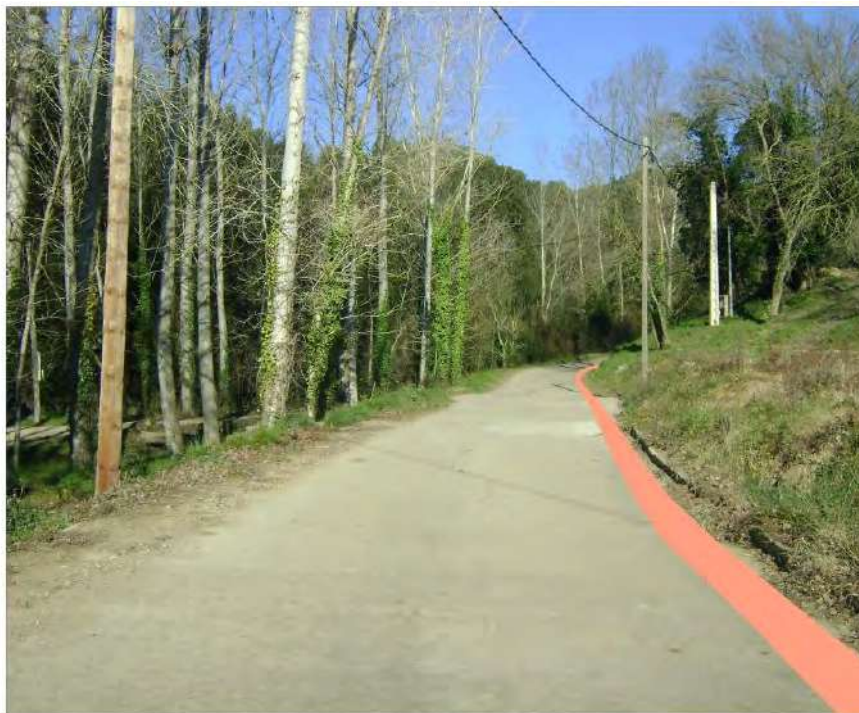
Imatge 7: Traçat de la rasa per la línia de mitja tensió subterrània pel camí del Terme
