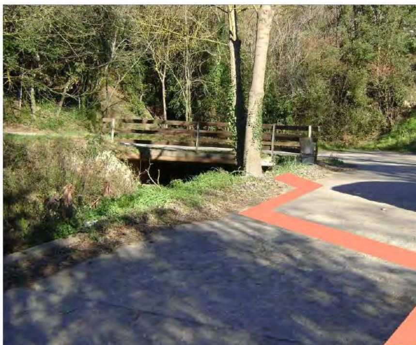
Imatge 8: Traçat de la rasa per la línia de mitja tensió subterrània creuant el Torrent de l'Estrader
