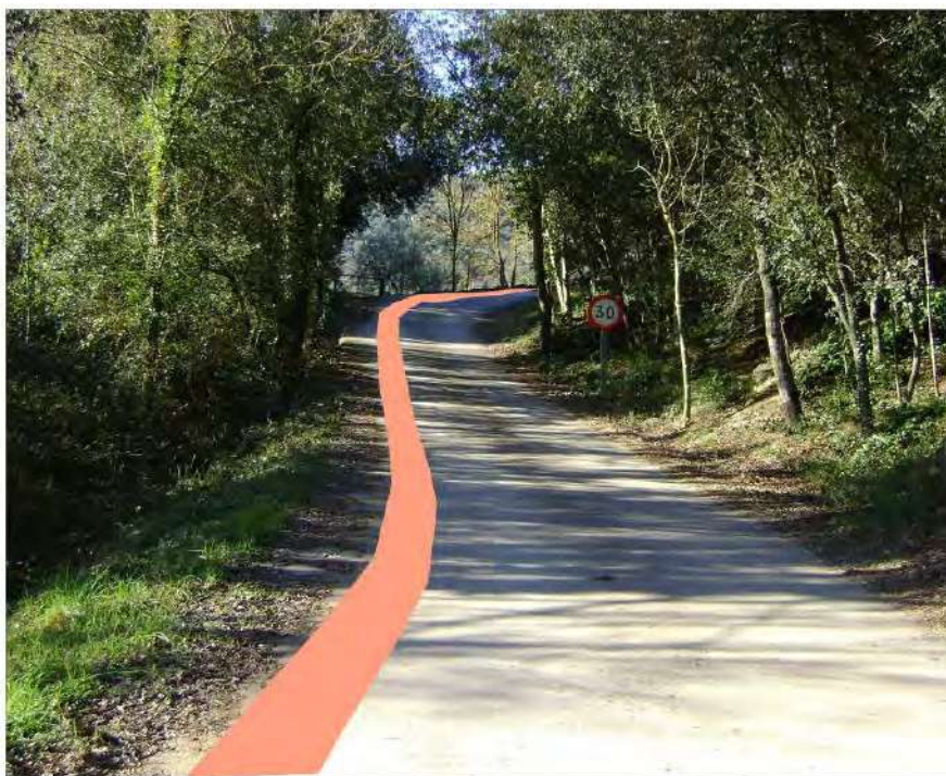
Imatge 9: Traçat de la rasa per la línia de mitja tensió subterrània pel camí del Terme
