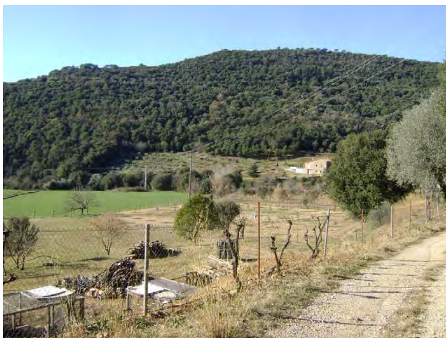
Fotografia 6: Línia aèria de mitja tensió que dona subministrament al CD DGI-10
