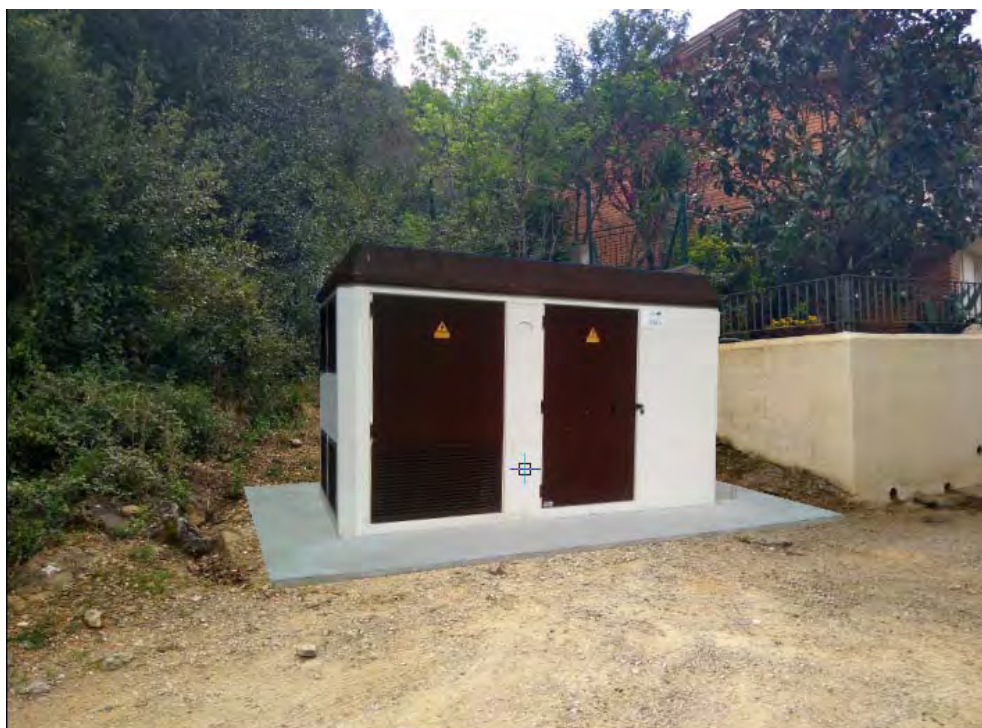
Imatge 4: Vista de la nova ubicació del nou CD DGI-36 "LLORÀ NORD"
