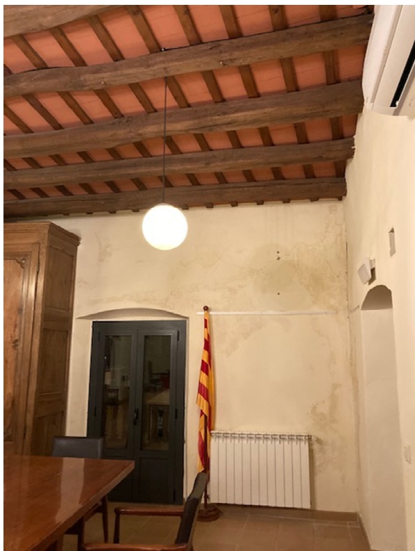
Fotografies de les humitats de les parets interiors (façana principal) de la sala de plens de la planta primera.
