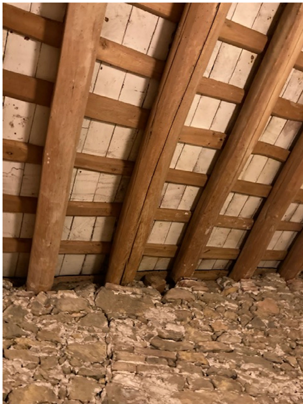
Fotografies estat actual del forjat de la coberta, esquerdes i parts per rejuntar de les parets de pedra del vestíbul distribució de la planta primera.
