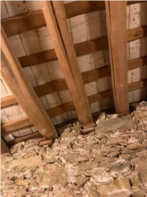
Fotografies estat actual del forjat de la coberta, esquerdes i parts per rejuntar de les parets de pedra del vestíbul distribució de la planta primera.
