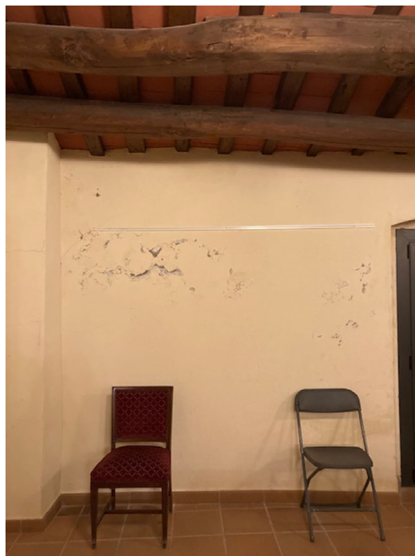
Fotografies de les humitats de les parets interiors (façana posterior) de la sala de plens de la planta primera.
