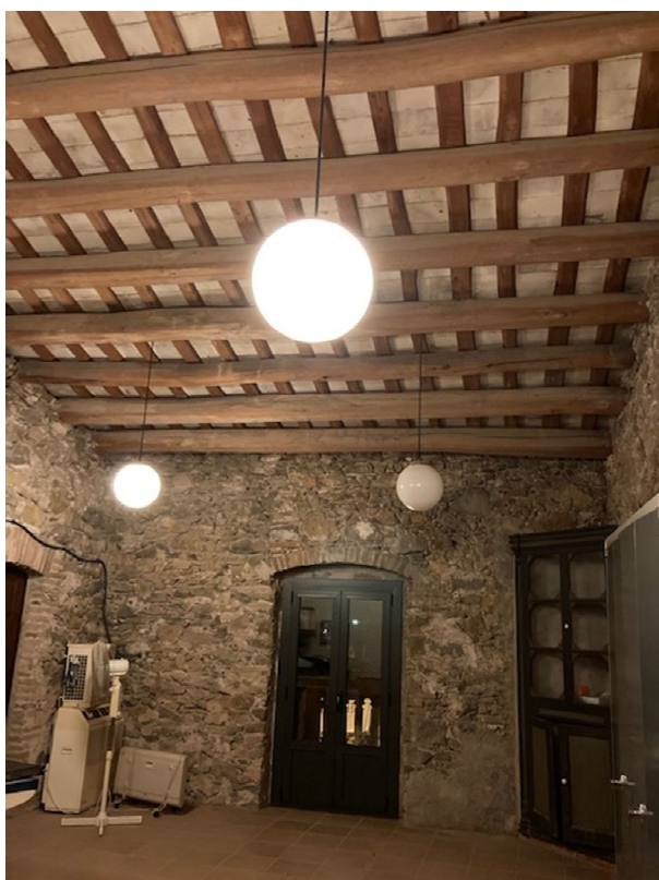
Fotografies estat actual de la coberta - sostre forjat planta primera del vestíbul de distribució.
