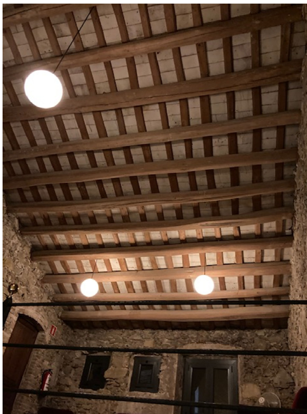
Fotografies estat actual de la coberta - sostre forjat planta primera del vestíbul de distribució.
