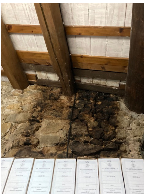
Fotografies de l'estat de les parets de pedra d'entrega amb el forjat de la coberta – sostre planta primera de l'arxiu.
