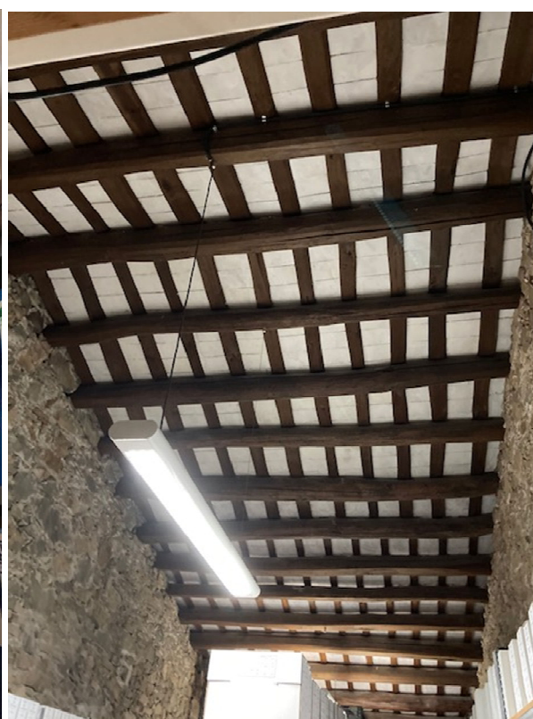
Fotografies de l'estat del forjat de coberta – sostre planta primera de l'arxiu.
