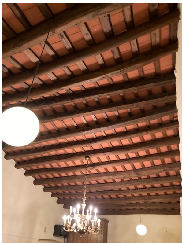
Fotografies de l'estat del forjat de coberta – sostre planta primera de la sala de plens.
