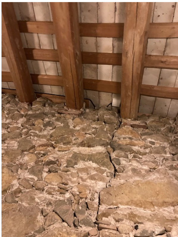
Fotografies estat actual del forjat de la coberta i esquerdes parets de pedra del vestíbul de distribució de la planta primera.
