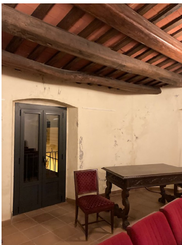
Fotografies de les humitats de les parets interiors (façana posterior) de la sala de plens de la planta primera.
