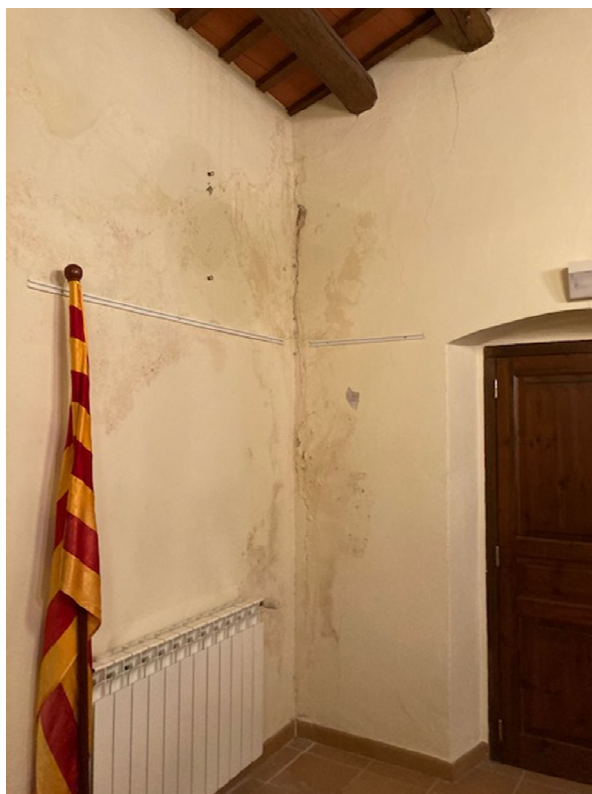
Fotografies de les humitats de les parets interiors (façana principal) de la sala de plens de la planta primera.
