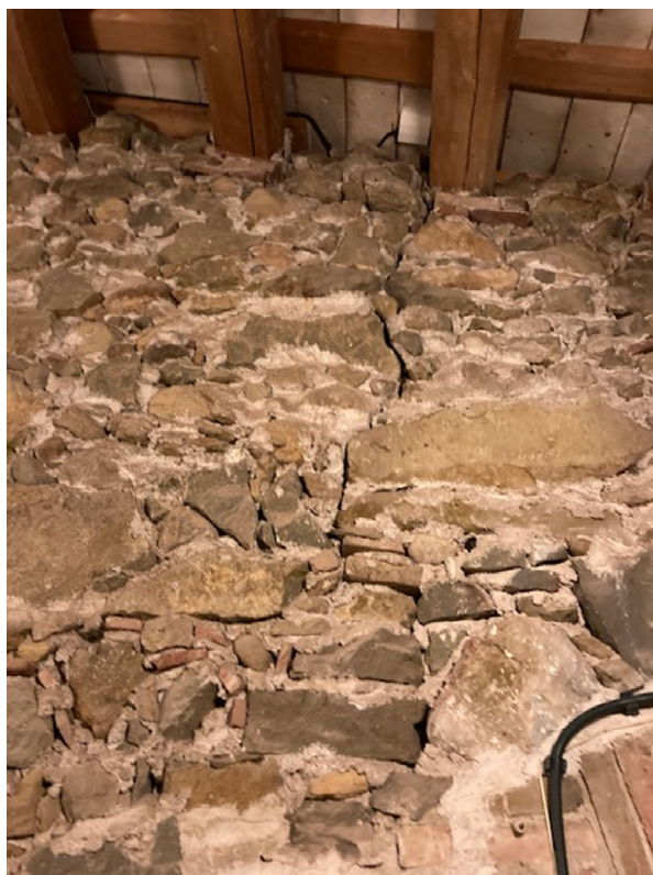
Fotografies estat actual del forjat de la coberta i esquerdes parets de pedra del vestíbul de distribució de la planta primera.
