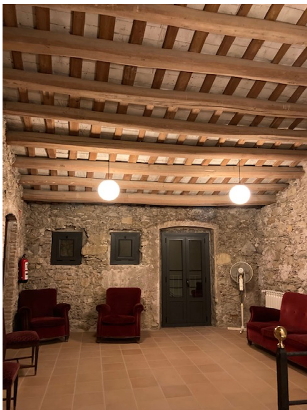
Fotografies estat actual de la coberta - sostre forjat planta primera del vestíbul de distribució.
