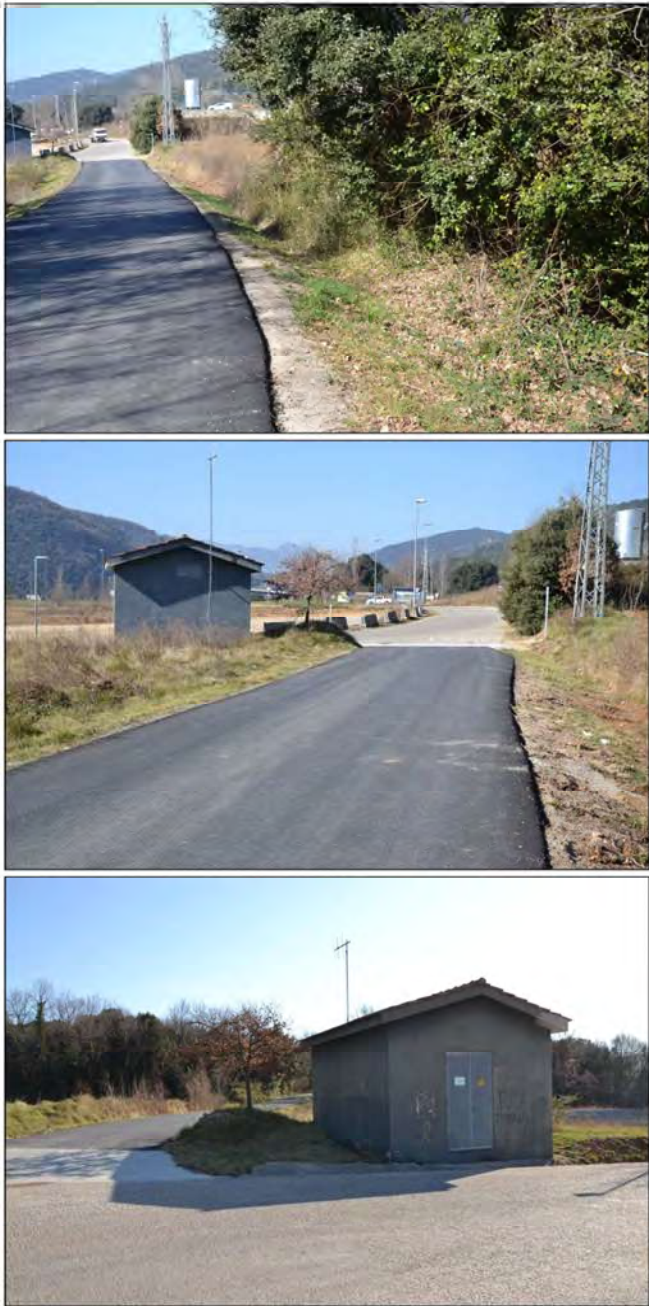
28 a 30. El darrer tram de la línia segueix la carretera pel marge nord fins a creuar-la just al finalde la línia.
