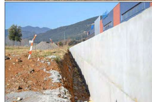
13 i 14. Dos detalls del sector davant l'empresa Tavi. Les obres de construcció del mur de contenció permeten veure el subsòl en secció fins a una certa fondària.
