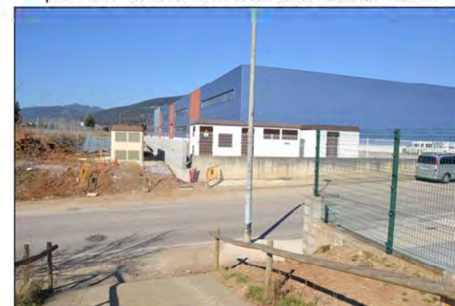
15. Punt final de la línia d'evacuació a l'est.
