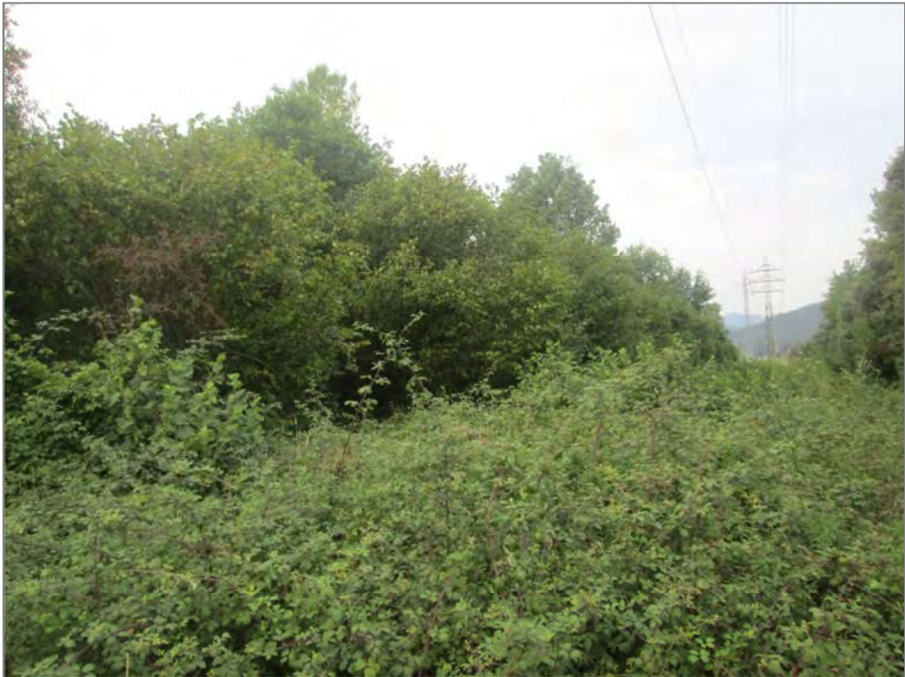
Fotografia 11. Vista actual de la zona boscosa existent a l'oest del terreny on s'implantarà la SE Poliger. Al fons vista de la línia de 132 kV existent.
