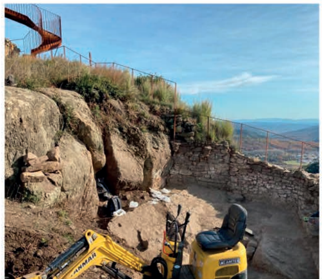
Obres de restauració del Castell d'Hostoles
