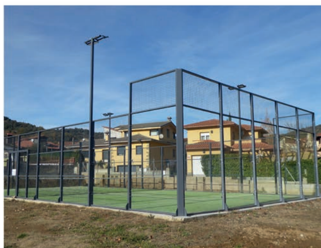
Nova pista de pàdel
