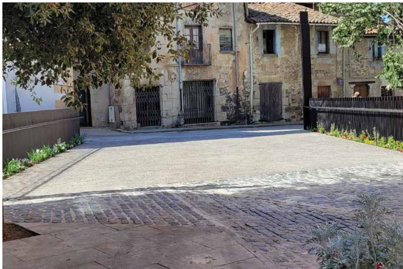
Reforma i ampliació del Pont. Any 2022
