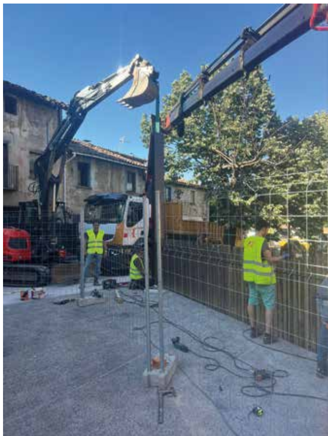
Treballs de remodelació del pont. Primavera 2022
