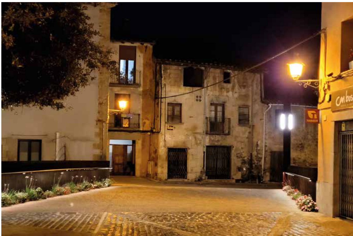
Reforma i ampliació del Pont. Any 2022
