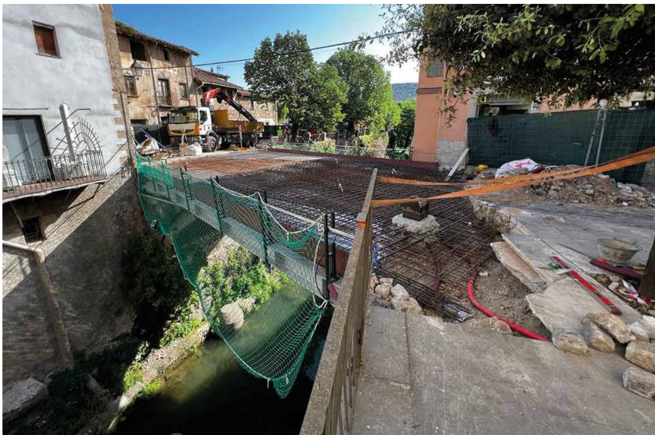
Reforma i ampliació del Pont. Any 2022
