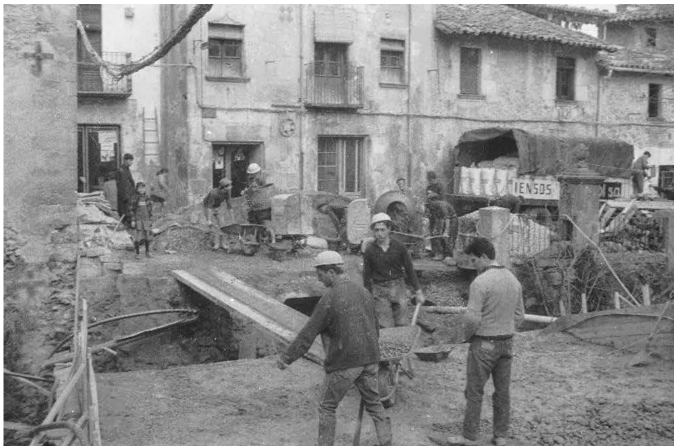
Reforma i ampliació del Pont. Any 1960
