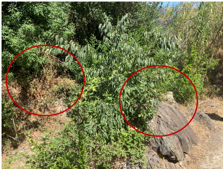
Figura 7. Pilars existents de recolzament
