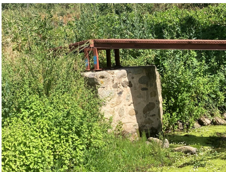
Figura 4. Pilars existents i recolzament
