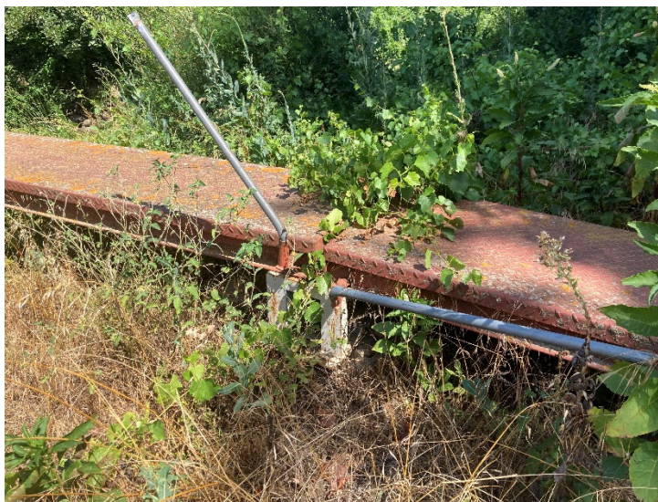
Figura 5. Estat actual baranes passera
