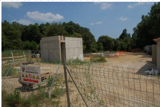
Figura. Obres de construcció de l'EDAR de Sant Aniol
