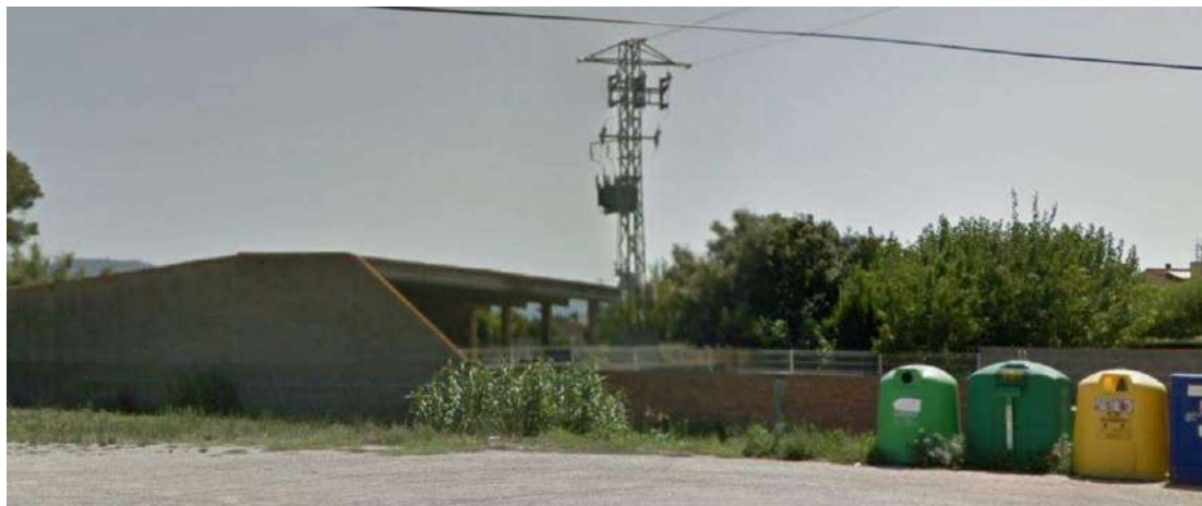
Imatges de la infraestructura elèctrica i serveis de la zona
