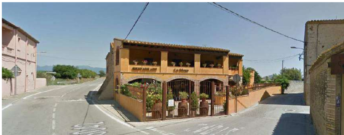
Imatge de l'àmbit des del sud-oest. Confluència dels carrers Major i Rossend Palmada
