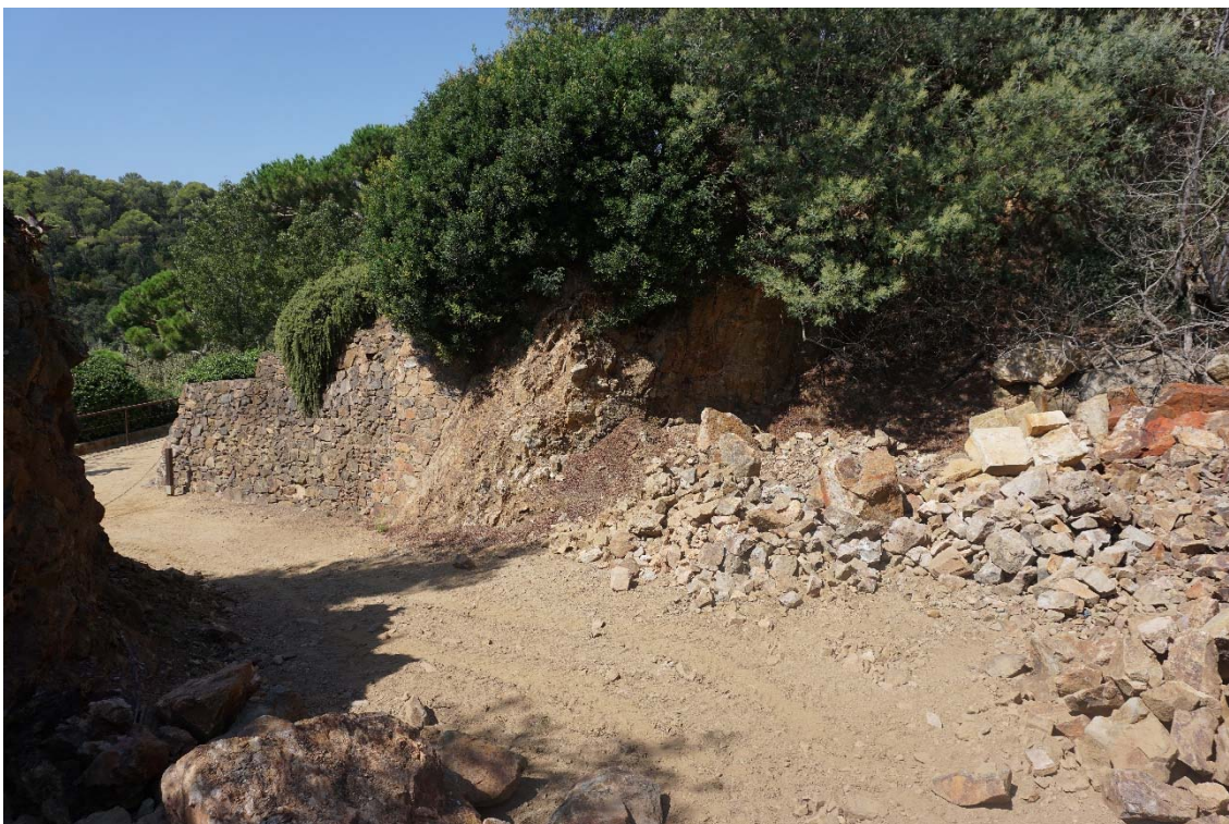
3 – Vista de l'interior mirant cap al camí principal
