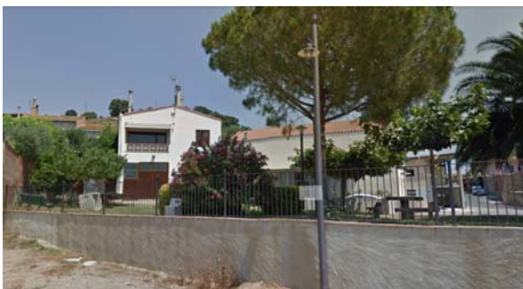
Perímetre zona verda amb barana protecció.
