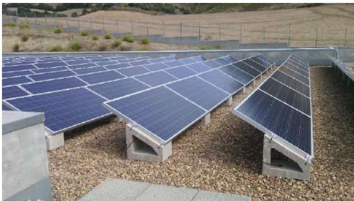
Fig. 9. Estructura auto-llastrant amb suports de formigó model SOLARBLOC (font: solarbloc.es)
