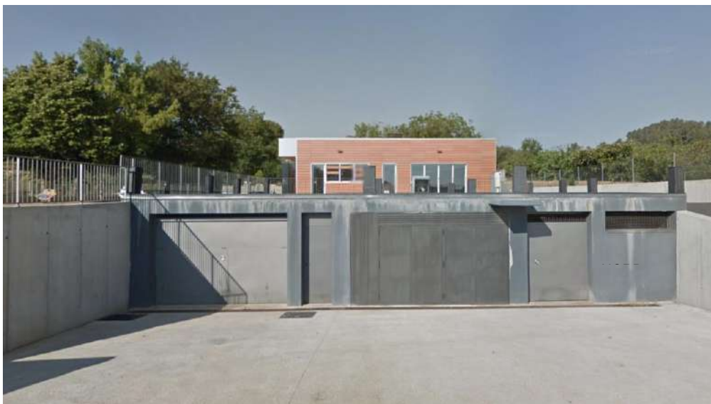
Fig. 1. Edifici Polivalent de Juià
