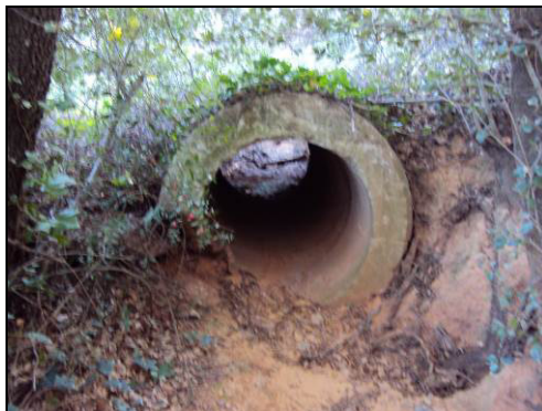
Vista de l'obra de drenatge circular en l'encreuament entre el camí rural i la llera del torrent innominat
