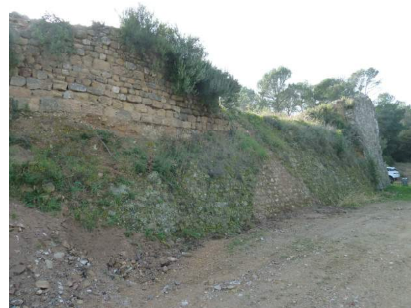
Figura 3: Vista parcial del mur nord de la fortificació. Hom hi pot observar com el fossat fossat fou aprofundit, la qual cosa descarnà la base del mur –observi's la part central de la fotografia-; alhora que la base es reforçà mitjançant la construcció d'una escarpa d'obra.
