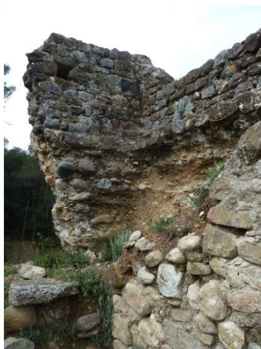
Figura 2: Vista de la part superior de la torre de la cantonada nord-oest. Hom pot observar com el full interior només existeix a la part superior, mentre que a la inferior es veu el terra natural.
