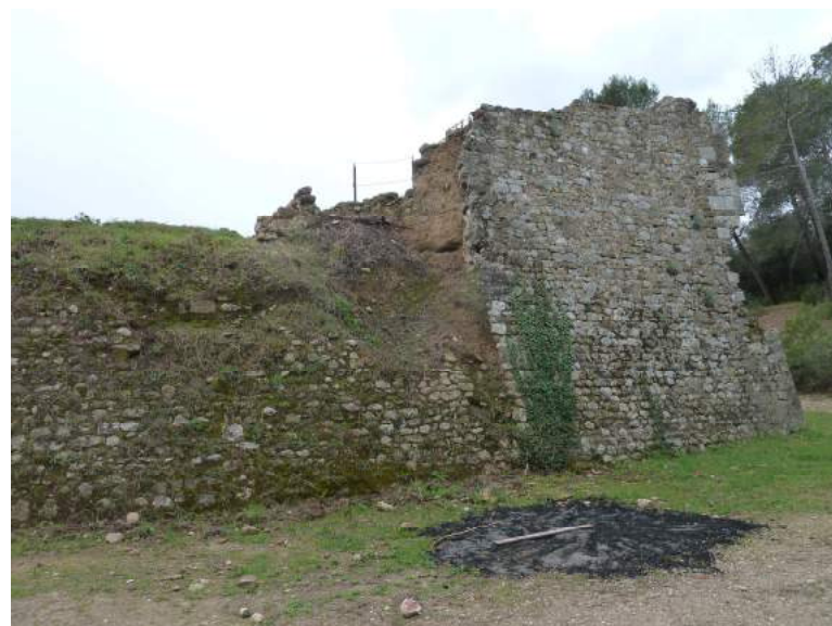
Figura 1: Vista general de la "torre de l'homenatge", dreta de la imatge, i del mur nord del castell. Hom hi pot observar el terrible pillatge que ha patit el conjunt, de manera que han desaparegut bona part dels carreus, sobretot els cantoners. Alhora, a la part superior també es pot veure com el mur folrava el terreny natural, la qual cosa sembla indicar que el castell es bastí rebaixant el terreny.
