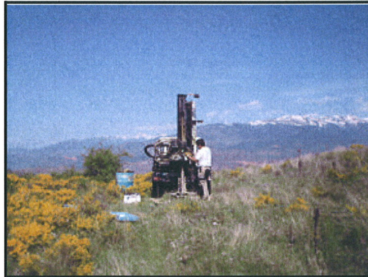
Foto 4: Situació i execució sondeig S2.770-09.
