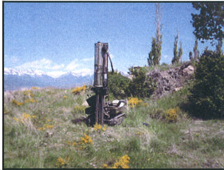
Foto 8: Situació i Execució assaig P2.770-09
