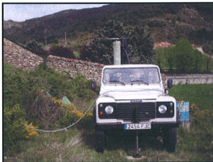
Foto 1: Situació i execució sondeig S1.770-09.
