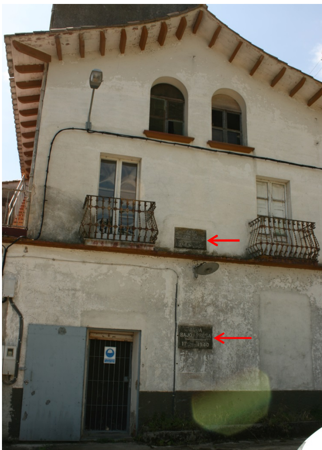
Fotografia 4. A l'edificació de la presa de Martís hi ha dues plaques a la façana que indiquen on va arribar l'aigua a sobre i a sota la presa el 17 d'octubre de 1940.
