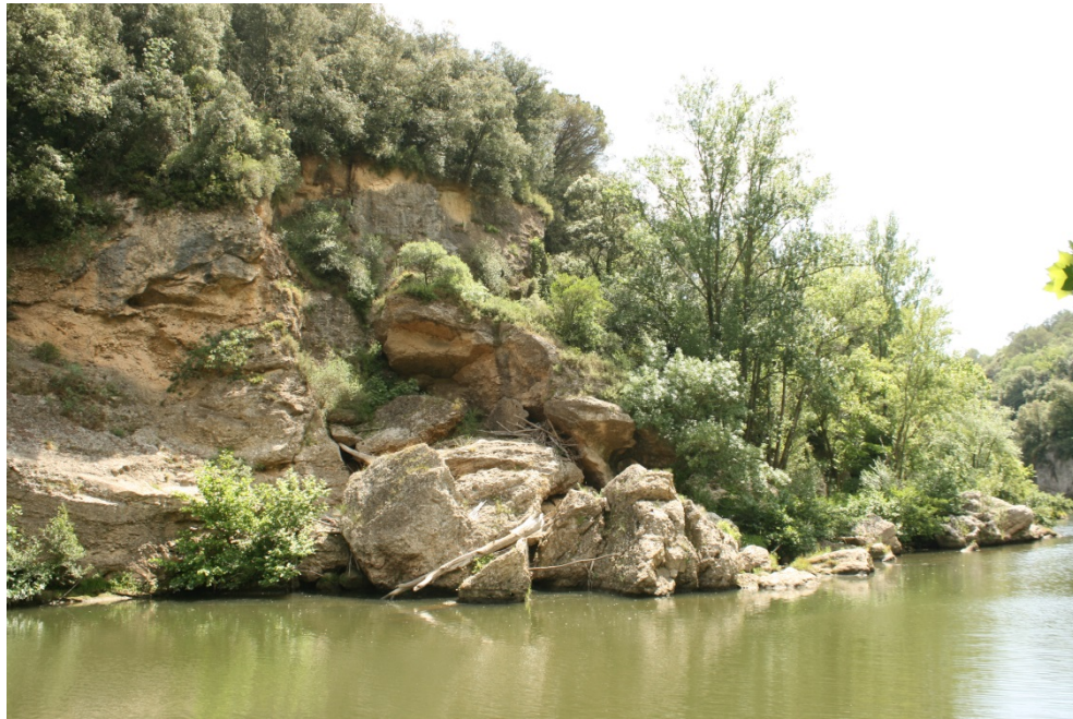
Fotografia 3. Despreniment antic sota la presa de Martís.
