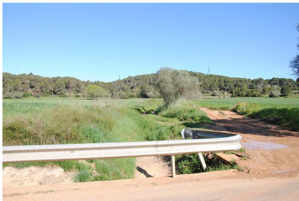
Foto8. Rec de les Cogullades aigües amunt de la carretera GIP-5121
