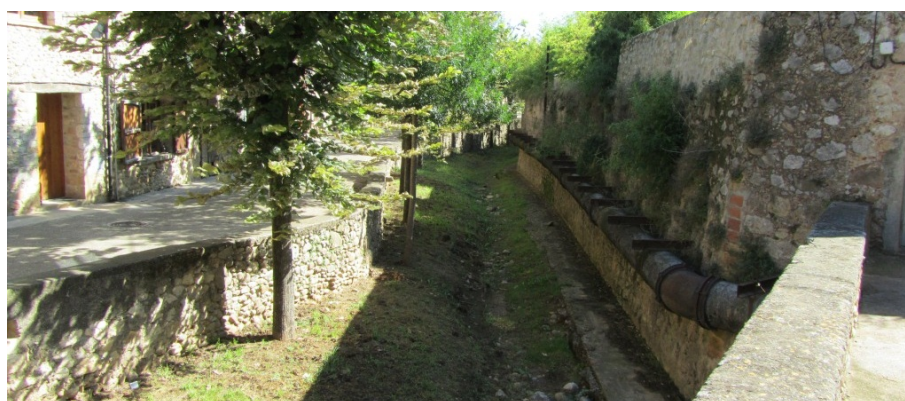
Figura 17. vista de la llera del torrent Merler a l'interior del nucli urbà de Crespià.
