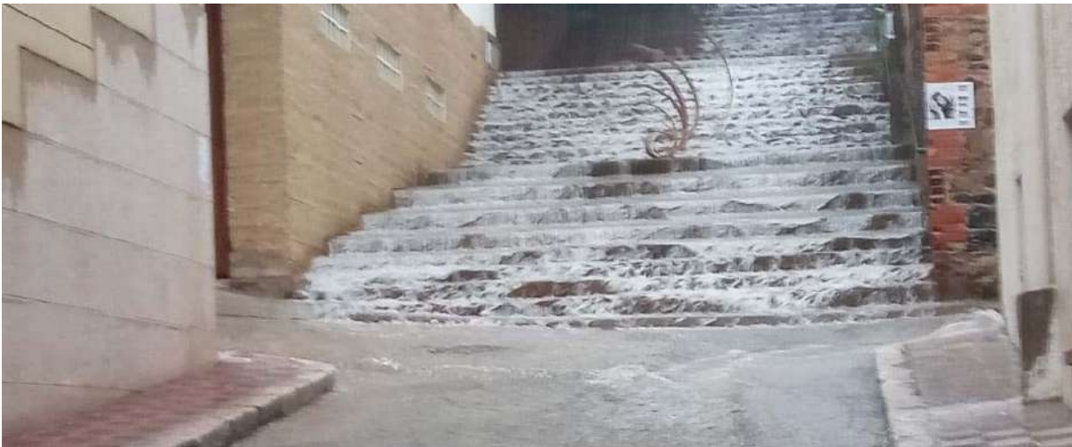
Àmbit de la reforma en un episodi de pluges
