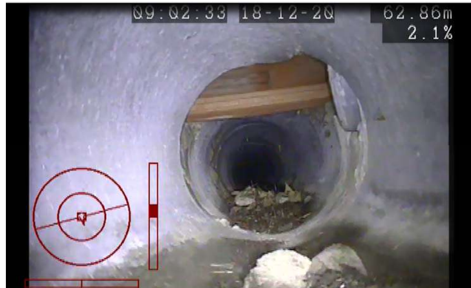
Estat interior del tub amb interferències d'altres serveis
