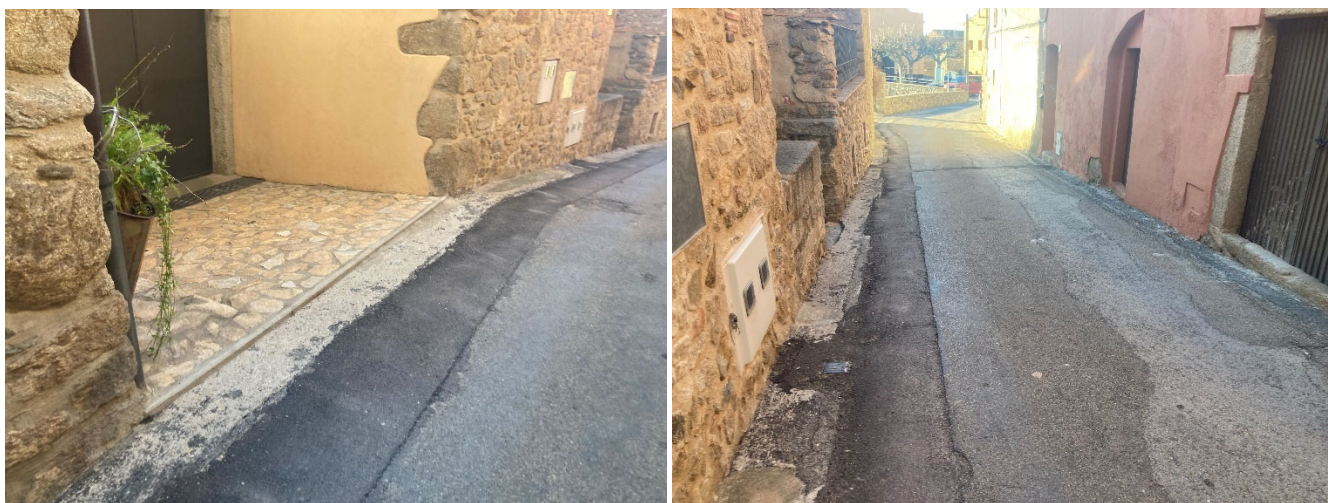
Figura 20. Vista Carrer Figueres i accessos laterals, tram posterior intersecció Carrer Bernat de Cantallops
