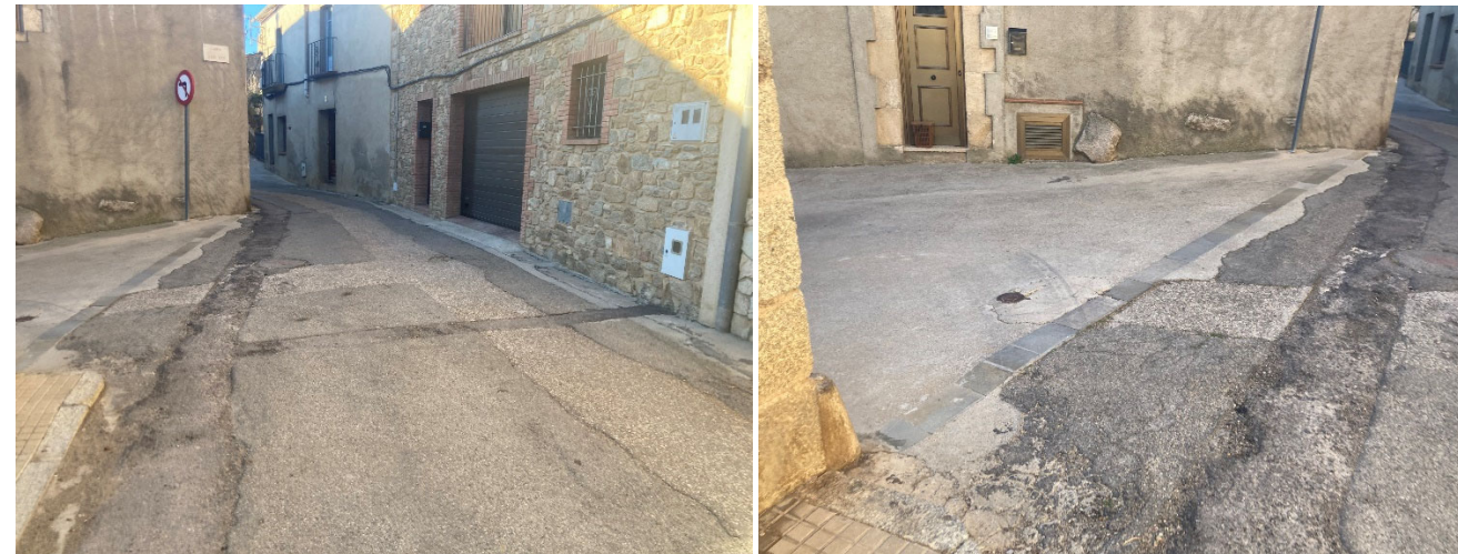
Figura 15. Intersecció Carrer Fgiueres amb Carrer Joan XXIII
