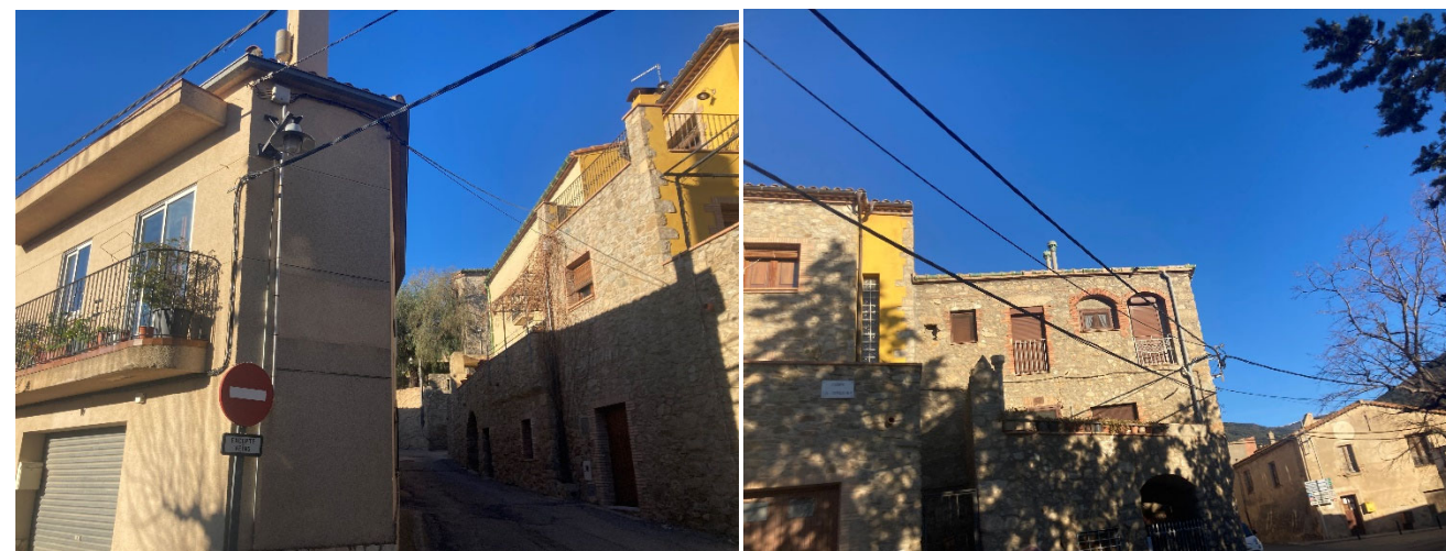
Figura 14. Vista creuament aeri zona intersecció Carrer Figueres amb Carrer de la Jonquera
