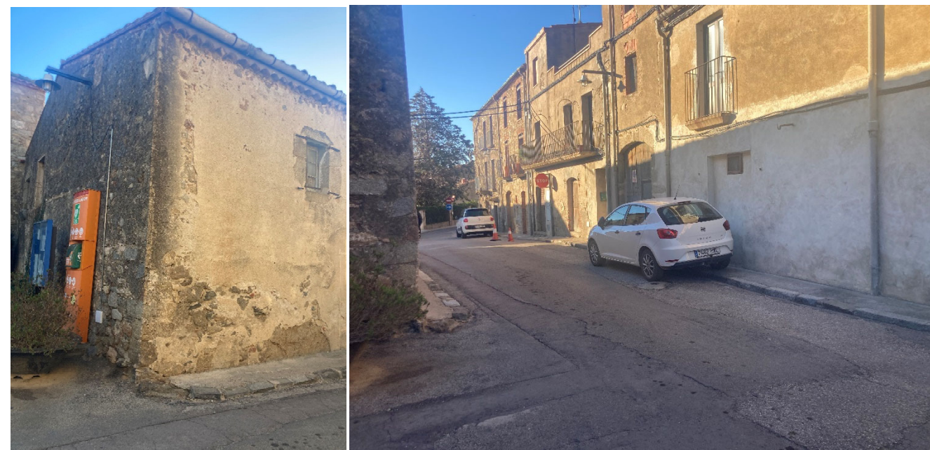
Figura 7. Vista inici àmbit Cantonada Carrer Figueres amb Plaça del Fort
