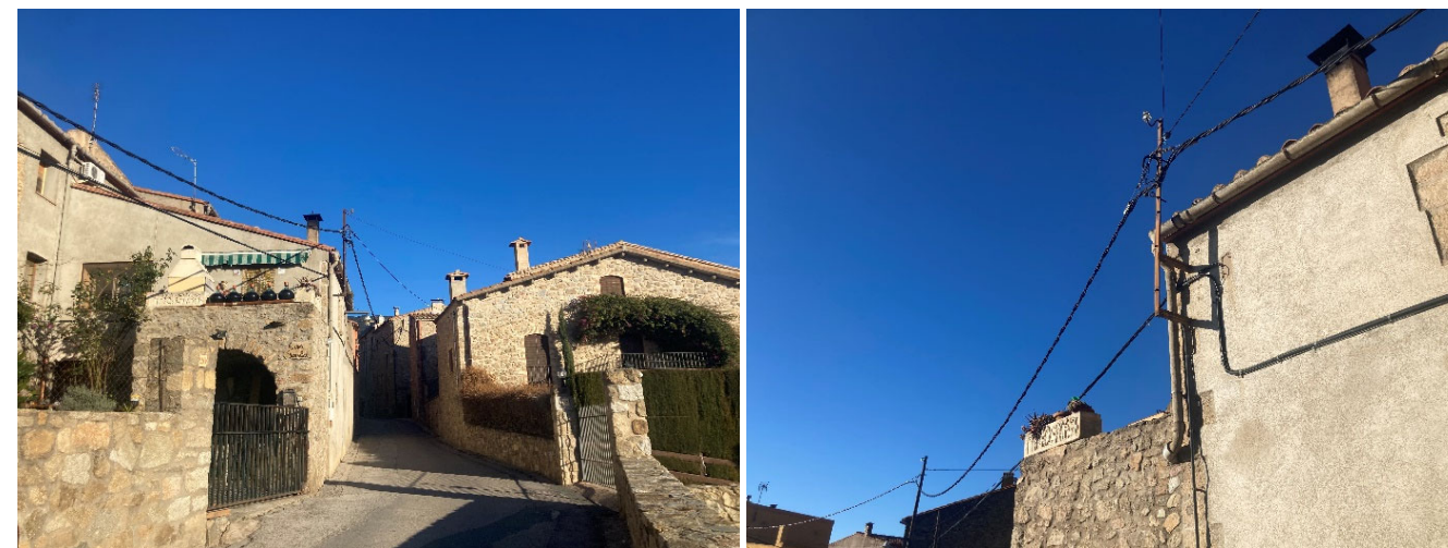
Figura 22. Vista tram final Carrer Figueres direcció Nord, s'aprecien creuament aeris de serveis
