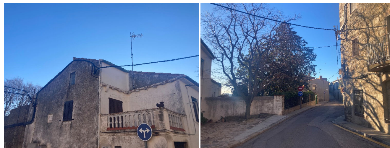
Figura 6. Conducció aèria per façana i creuament Carrer Figueres
