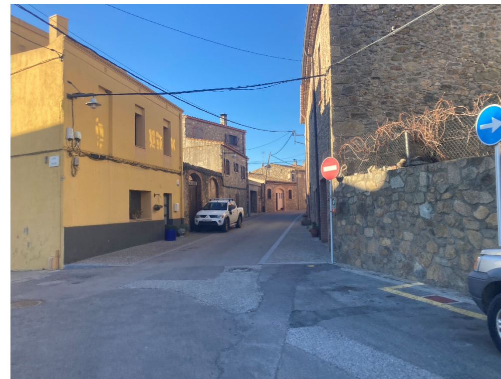
Figura 23. Fi àmbit actuació Carrer Figueres, vista creuament aeri serveis
