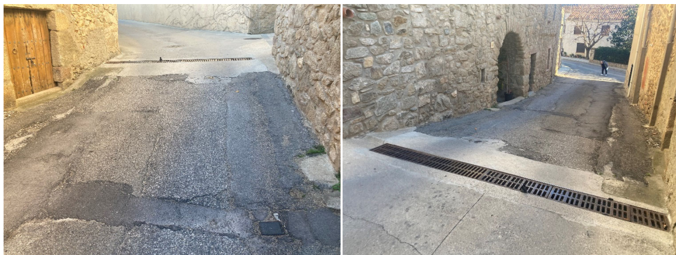
Figura 12. Vista fi àmbit actuació Carrer de la Jonquera
