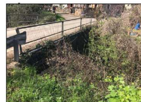
Imatge 4. Estat actual del marge nord
