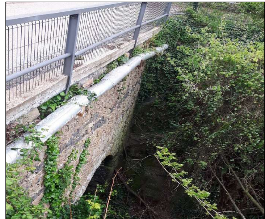
Figura 2. Vista lateral del pont des d'aigua avall.
