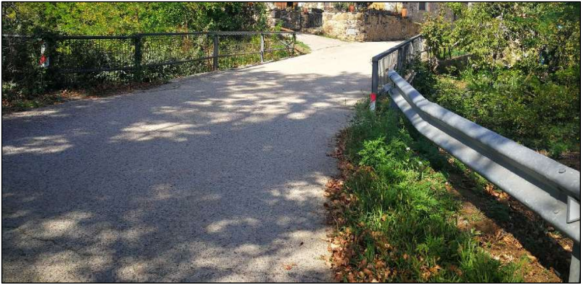
Figura 3. Vista del Pont d'Adri des de l'accés del marge dret.
