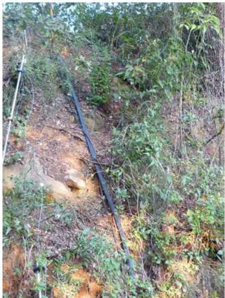
Instal·lació aigua (fase execució)
