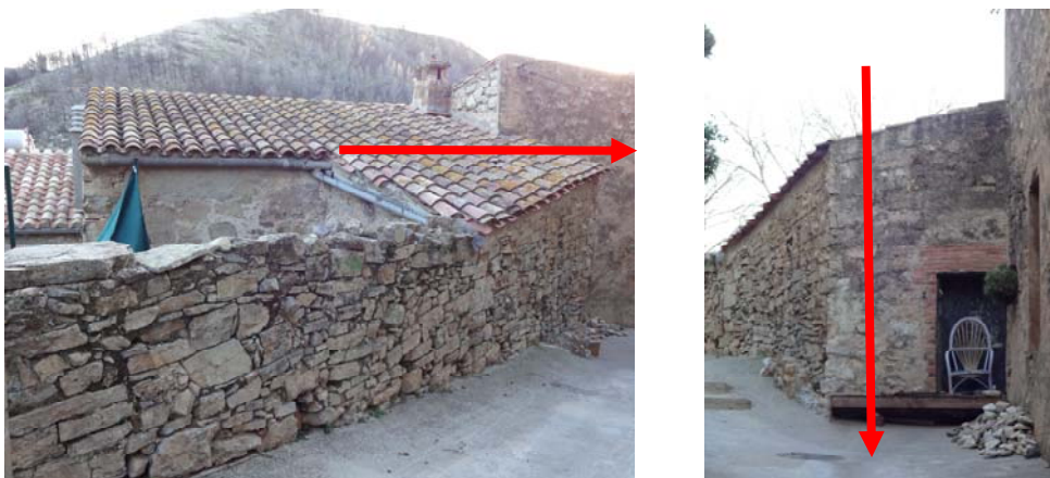
FOTOGRAFIES DEL VOLUM EDIFICAT AMB INDICACIÓ DEL COS A RETALLAR SEGONS LA PROPOSTA DE MODIFICACIÓ
