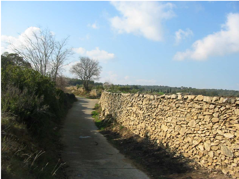
Murs de pedra seca als voltants de Capmany
