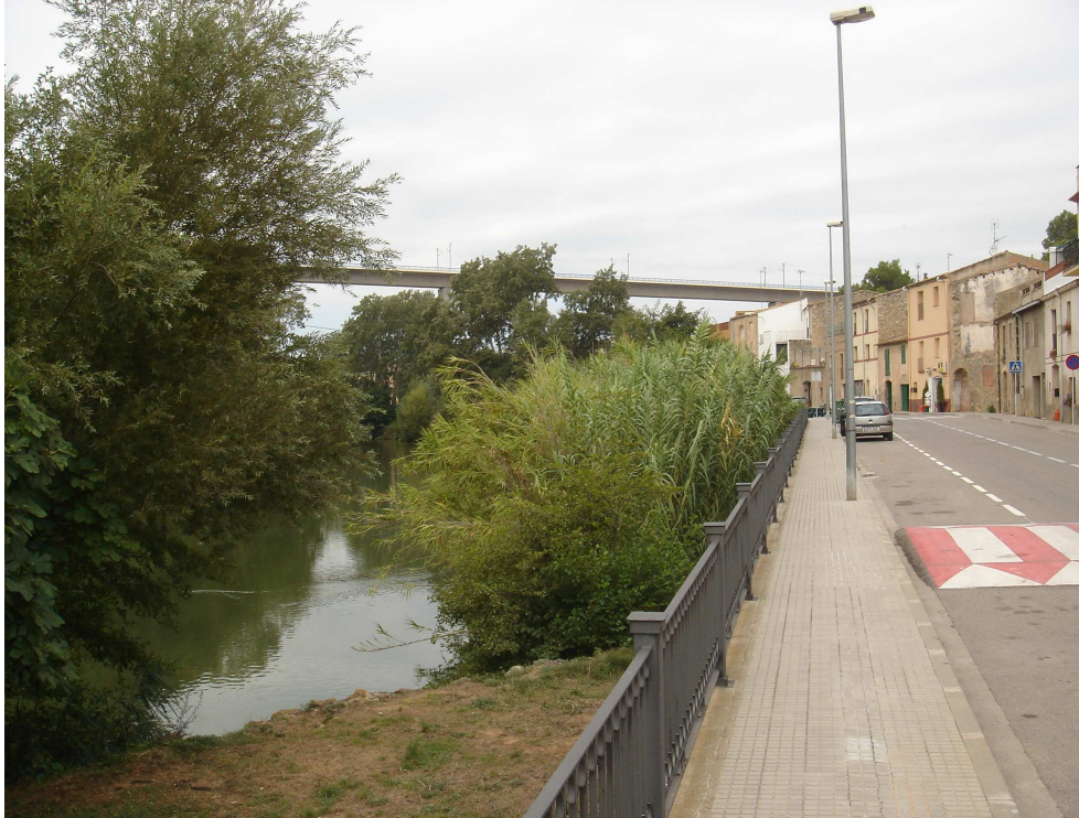
Viaducte TGV sobre el municipi de Pont de Molins
