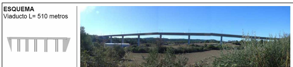
Viaducte sobre la Muga a Pont de Molins (Taller Ambiental per encàrrec del CILMA)
