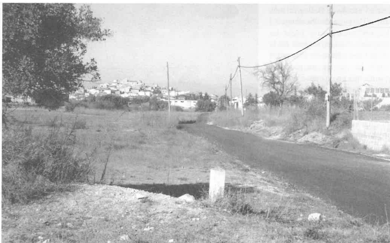
Camí d'Ullà pocs dies després de ser asfaltat.
