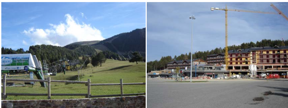
Fotos: instal·lacions de telecadira i edificis residencials de l'estació d'esquí alpí de la Molina, al municipi d'Alp
