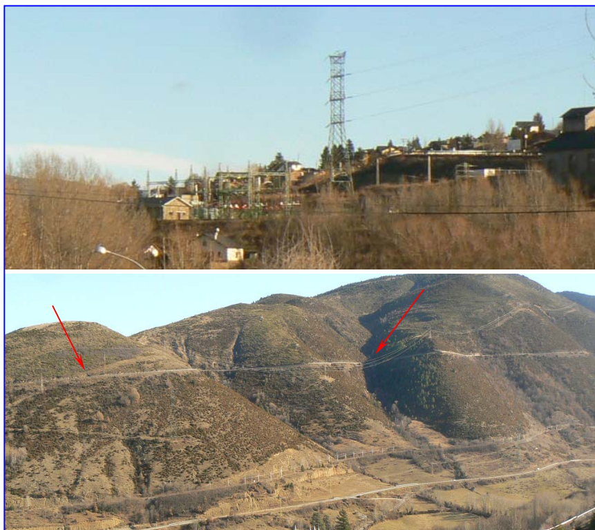
Fotos: En la fotografia superior podem observar la central elèctrica situada al municipi de Fontanals de Cerdanya llindant amb el terme d'Alp i a la imatge inferior veiem el transcurs de la línia d'alta tensió al llarg de les muntanyes dins del terme municipal d'Alp
