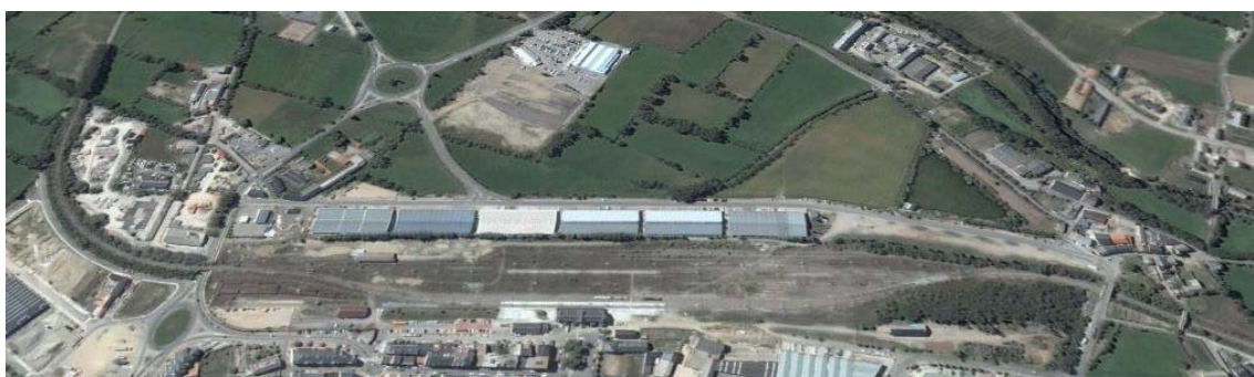
Foto. L'estació de ferrocarril de Puigcerdà. Font: Google Earth.
