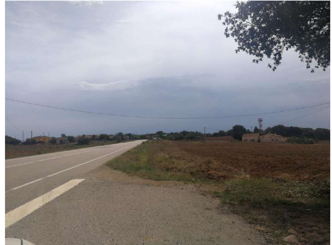
Imatge 35: Vista en sentit sud des de l'accés a Can Mestres (PK 1+200 de la carretera).
