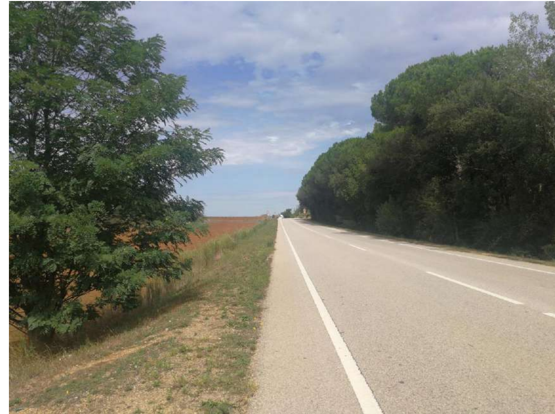
Imatge 39: Vistes del marge esquerra en sentit sud al PK 0+800 de la carretera.
