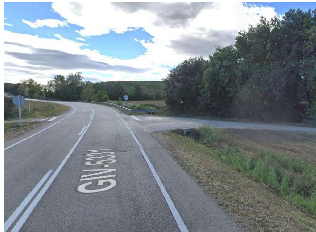
Imatge 28: Cruament amb camí veïnal al PK 1+900 de la carretera.
