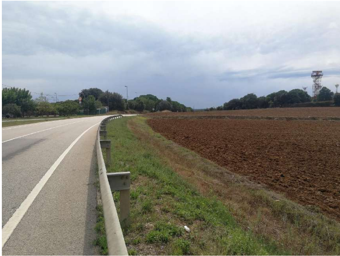
Imatge 37: Vistes en sentit sud del marge oest de la carretera al PK 0+900 de la carretera.
