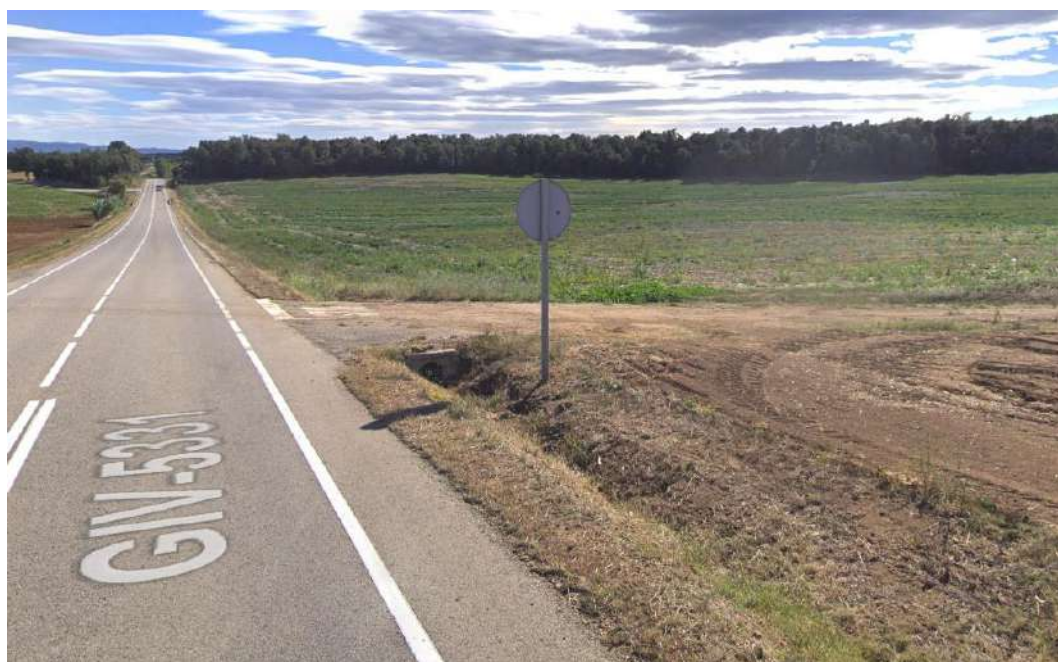
Figura 2: La via verda transcorrerà per el costat oest (dreta de la imatge) de la carretera GIV5331
