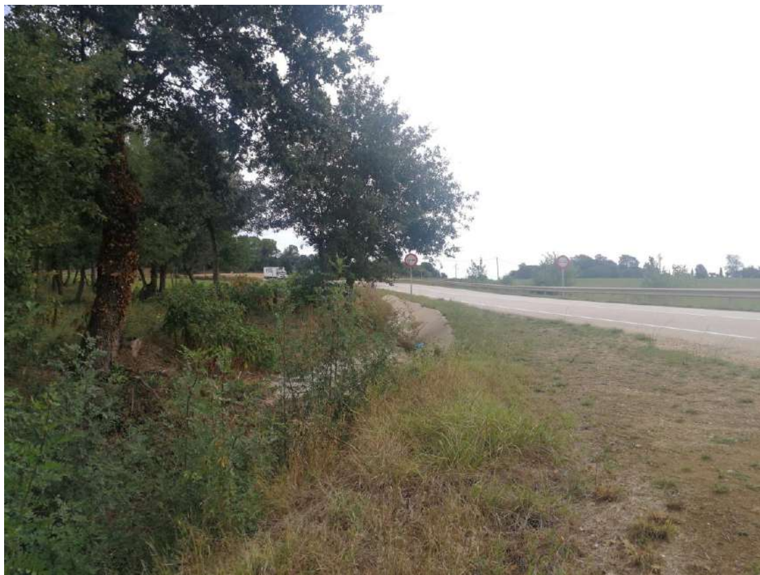
Imatge 25: Encreuament de la carretera amb la riera de la Torre al PK 2+000 de la carretera. Sentit nord.
