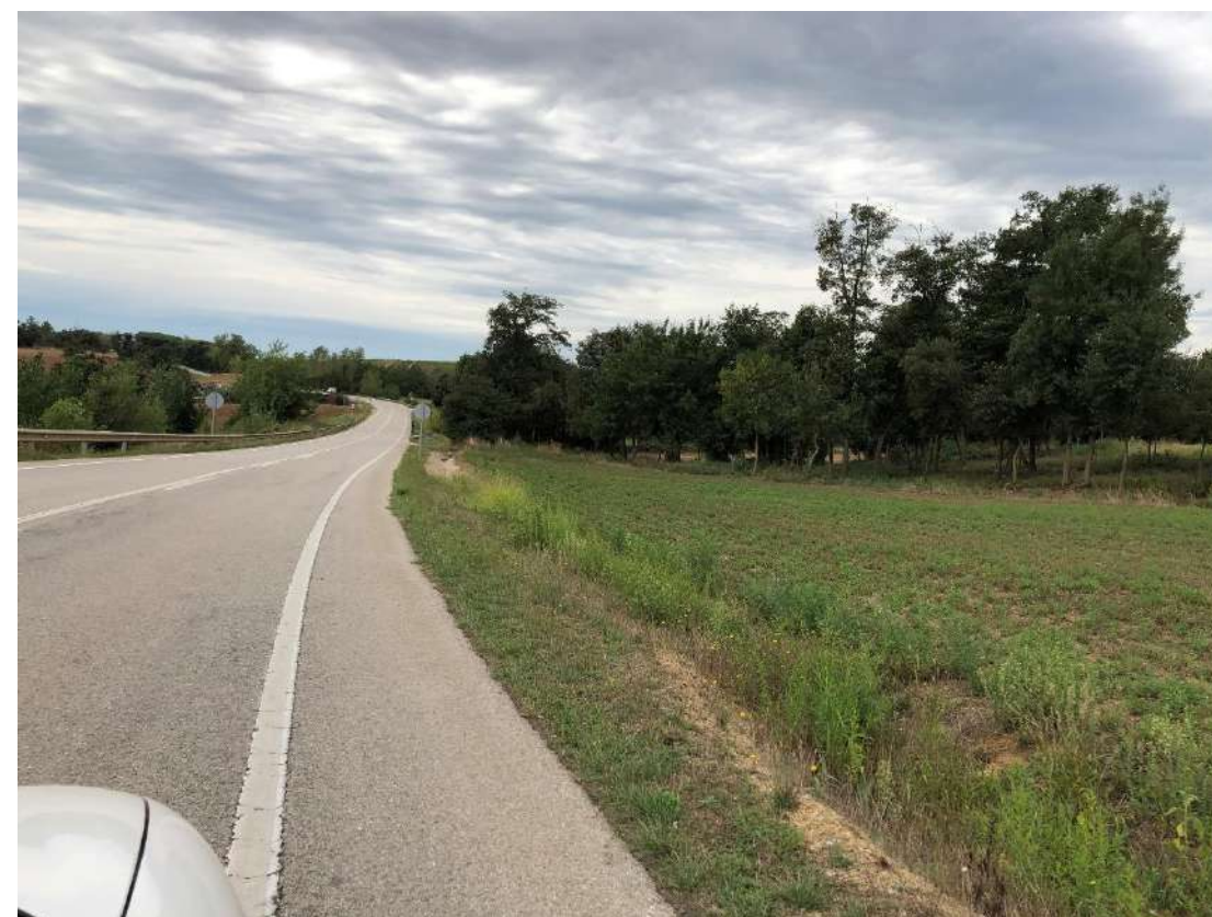
Imatge 24: Vistes del marge oest de la carretera a l'alçada de la Granja de la Capella. PK 2+100 de la carretera.
