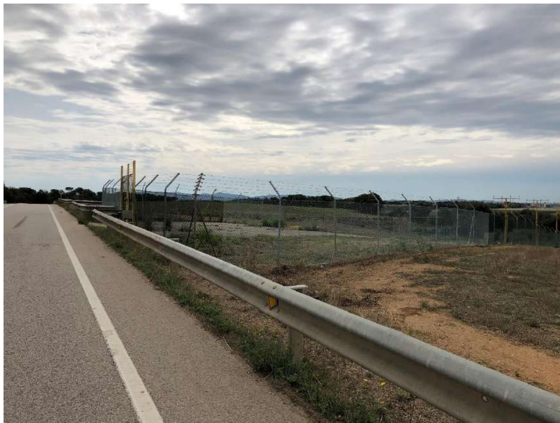
Imatge 21: Instal·lacions aeroportuàries existents al PK 2+950 de la carretera.
