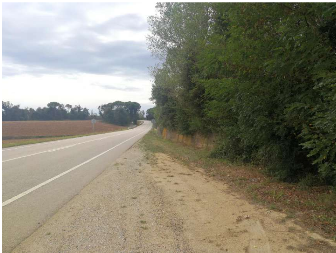
Imatge 30: Mur de contenció existent al marge esquerra de la carretera al PK 2+150 de la carretera.
