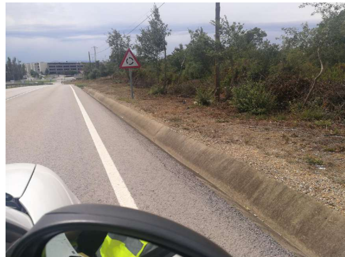
Imatge 40: Vistes del tram final, molt a prop del giratori al PK 0+400 de la carretera.
