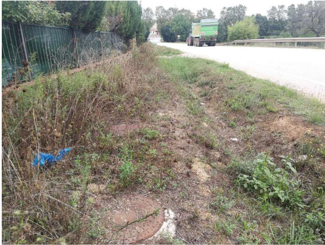
Imatge 9: Tanca perimetral de Can Jaques, al costat est de la carretera poc abans de la cruïlla del Veïnat del Güell.
