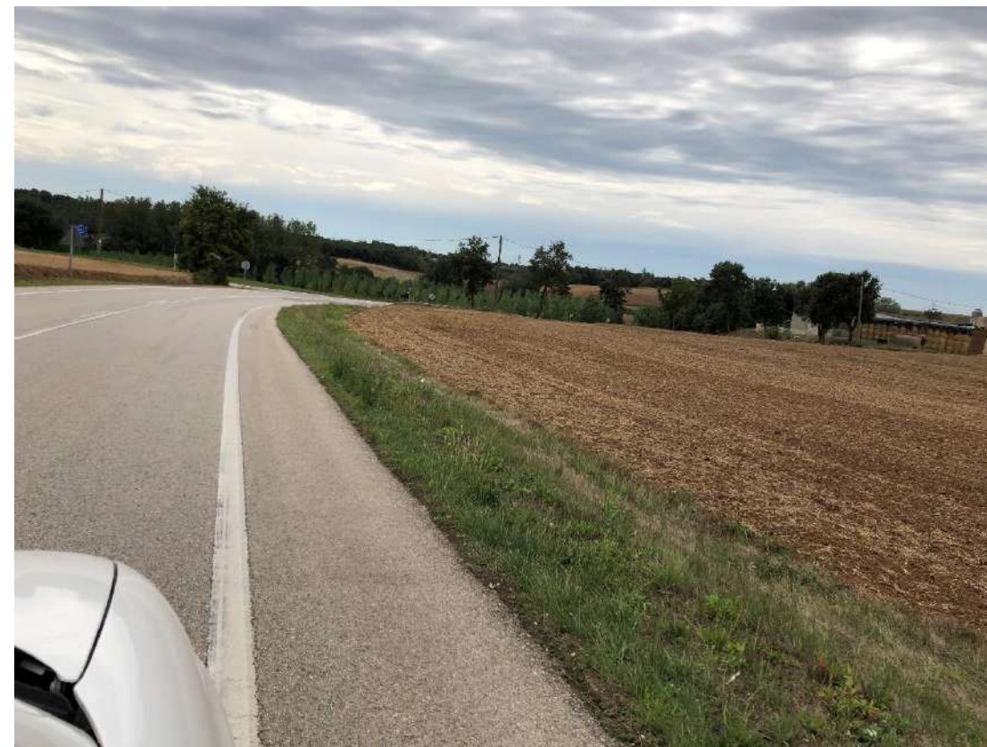
Imatge 23: Vistes del marge oest de la carretera a l'alçada de la Granja de la Capella. PK 2+350 de la carretera.
