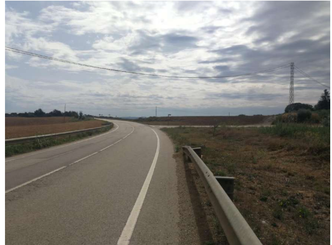
Imatge 19: Accés a la granja de Can Freser sobre el creuament amb la riera. PK. 3+050 de la carretera.
