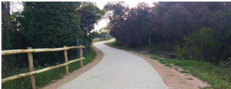
Figura 6: Paviment de sauló establitzat proposat, ja utilitzat a la via verda del carrilet
