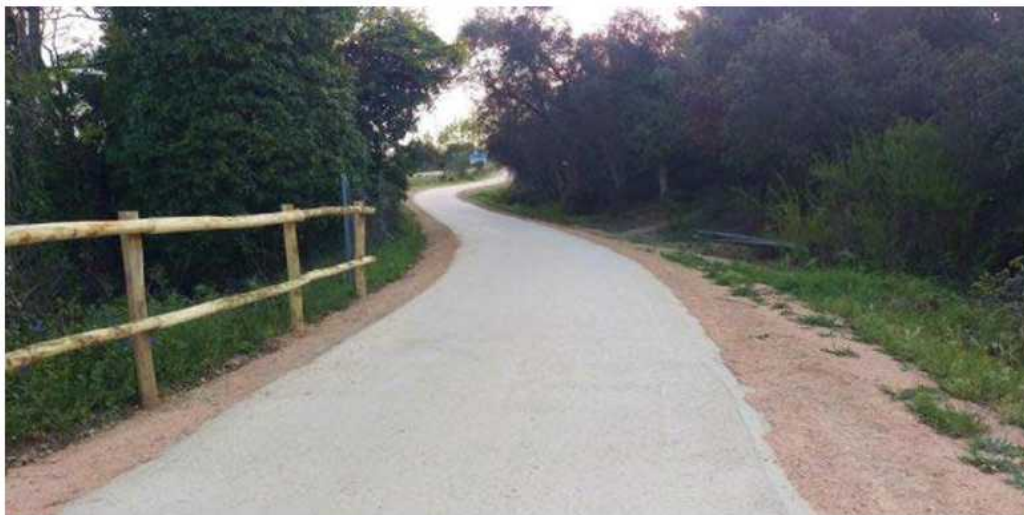
Figura 24:- Paviment de sauló estabilitzat executat a la via verda del carrilet
