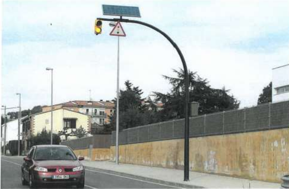
Proposta de semàfor intermitent amb alimentació fotovoltaica
