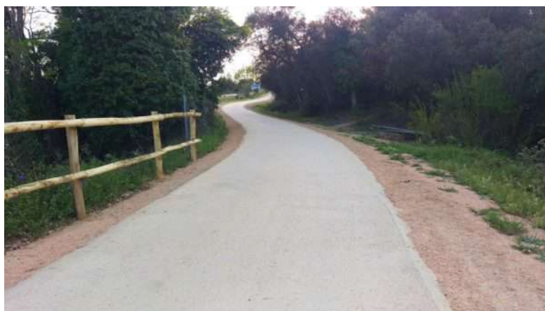
Paviment de sauló estabilitzat executat a la via verda del carrilet.
